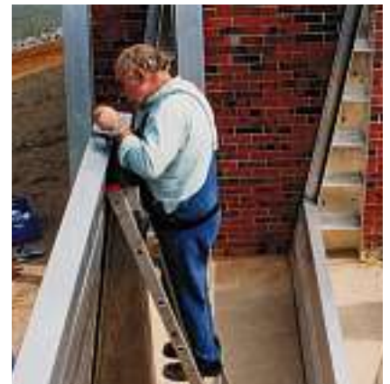
Dijkverhoging Zons – tijdelijke afsluiting van openingen in permanente hoogwaterkering
