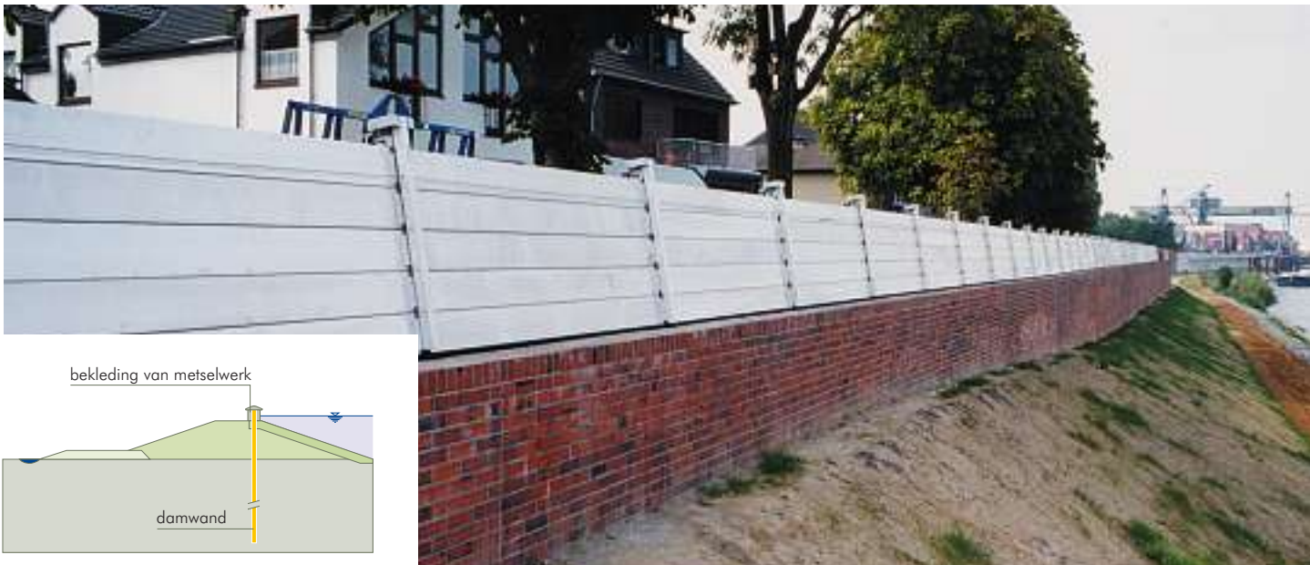
Dijkverhoging Zons – speciale “schotbalken” voor tijdelijke ophoging van de permanente hoogwaterkering
