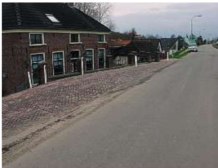
De dijk na voltooiing van het project
