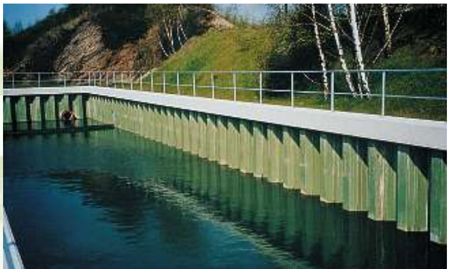
Opvangbekken voor regenwater, Lübeck, Duitsland
