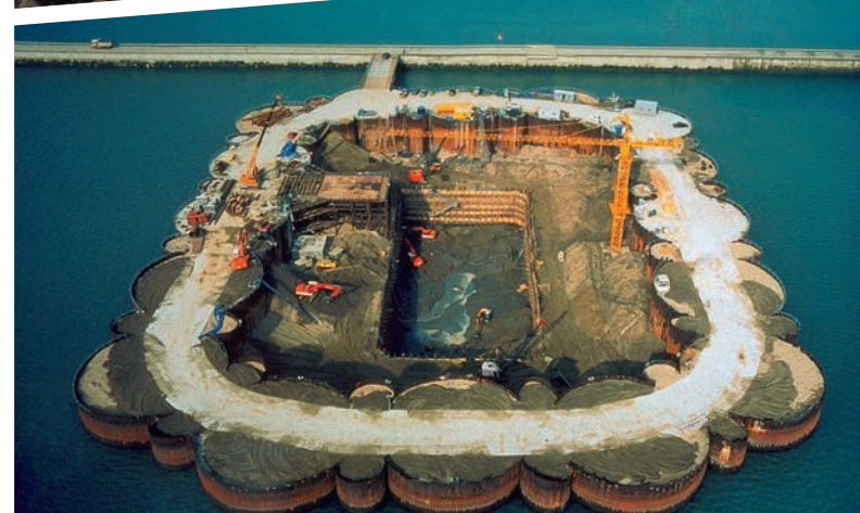
Bau eines Brückenpfeilerfundaments, Südkorea
