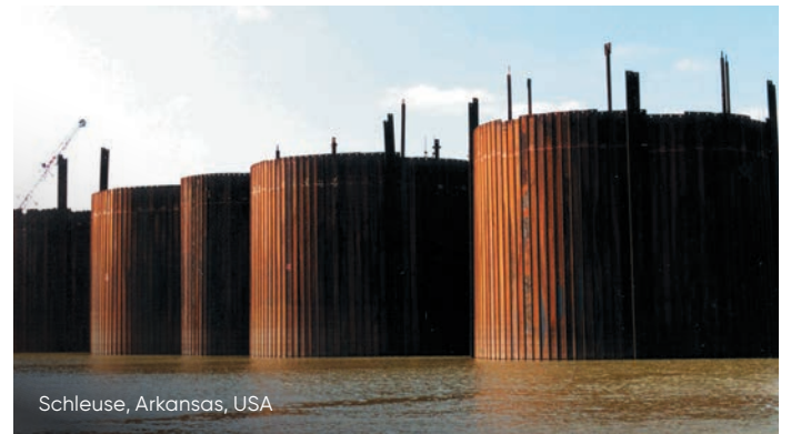
Flachzellen mit 120^\circ Abzweigbohlen.
