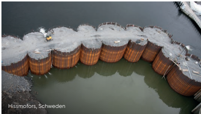
Kreiszellen mit 35^\circ Abzweigbohlen und einer Zickelwand oder zwei Zickelwänden.
