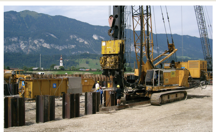
Fig. 11. Gabarito com um único nível e equipamento de cravação guiado graças a um líder fixo.
