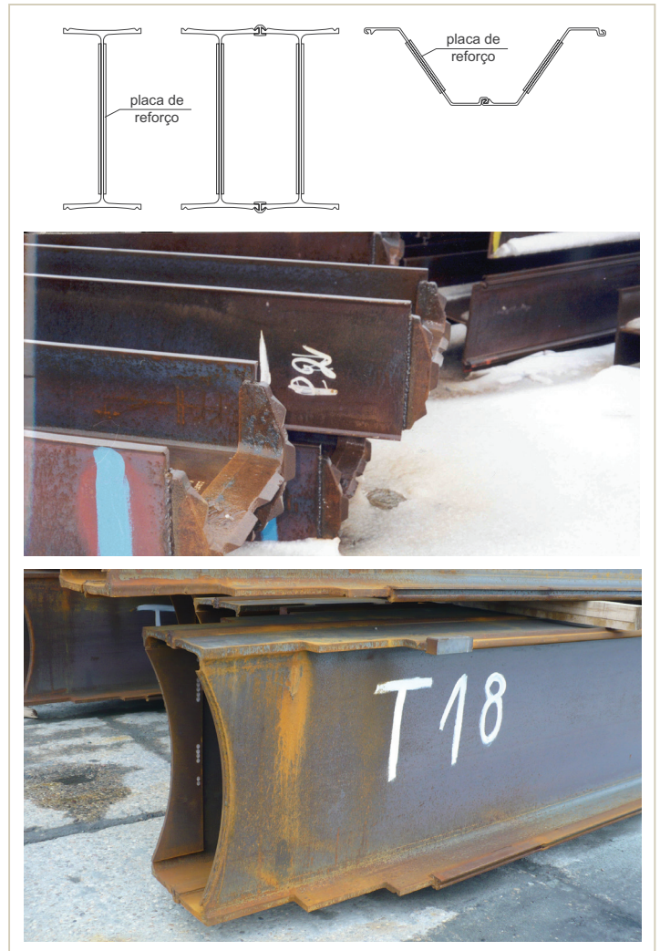
Fig. 17. Reforço da ponta da estaca com chapas / “pile shoes” soldadas na ponta da estaca.
