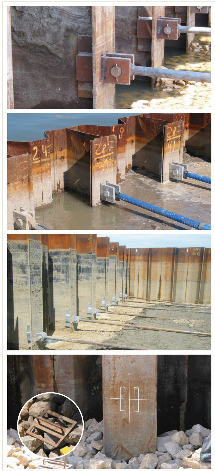
Fig. 5. Instalação dos conectores em T na obra.
