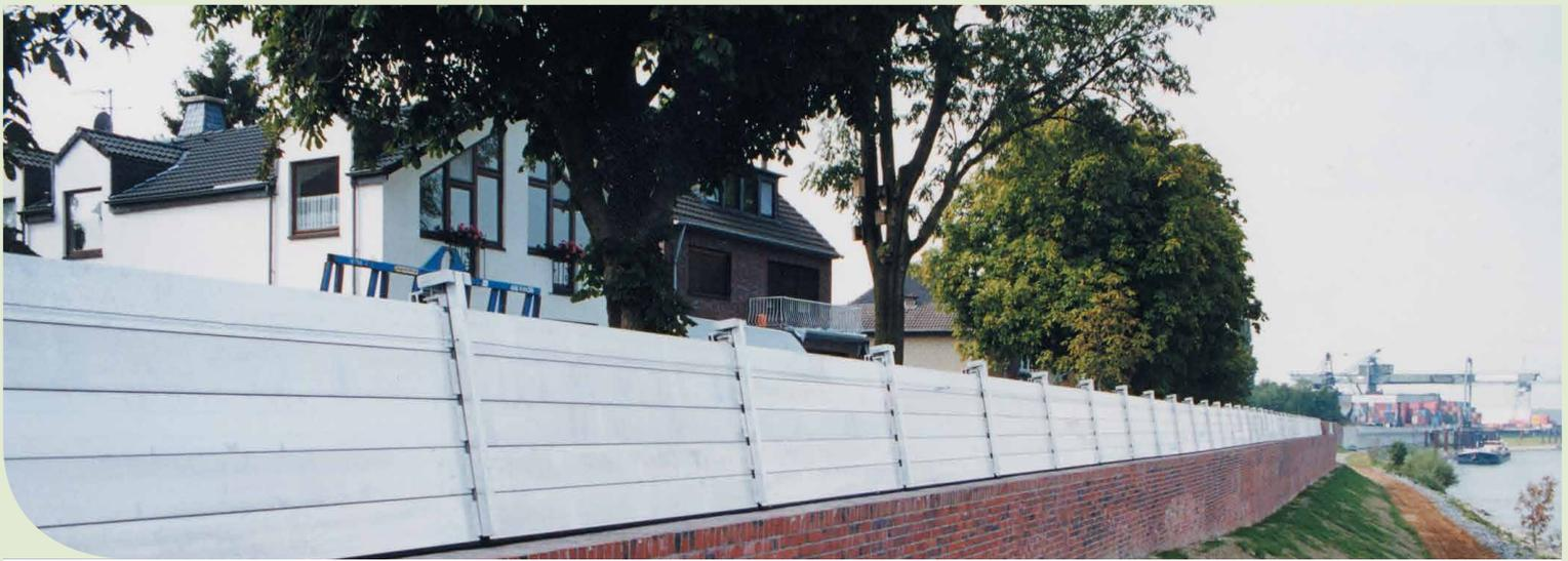
Deicherhöhung Zons – mobile Elemente als zeitlich begrenzte Erhöhung des permanenten Hochwasserschutzes
