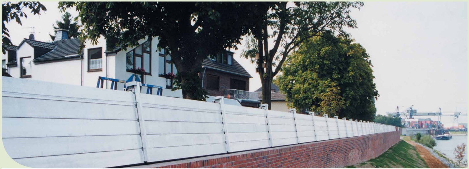
Surélévation de digue à Zons – éléments mobiles utilisés pour une surélévation temporaire de la protection permanente contre les risques de crue
