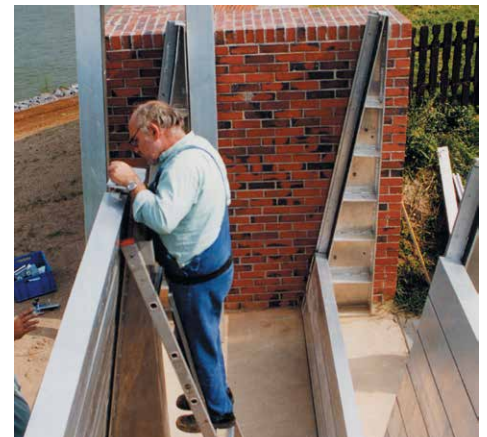
Surélévation de la digue à Zons – fermeture temporaire d'ouvertures dans la protection permanente anti-crue
