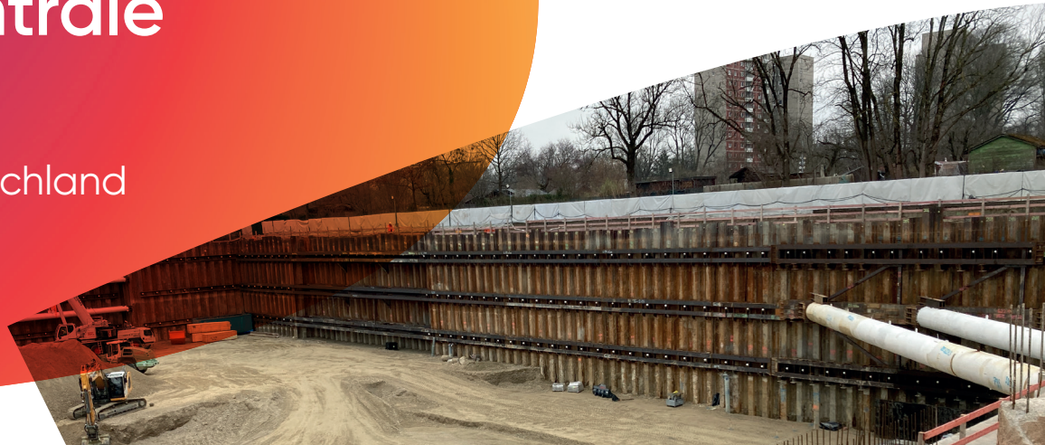
Spundwandverbau der Baugrube RS76 in München
