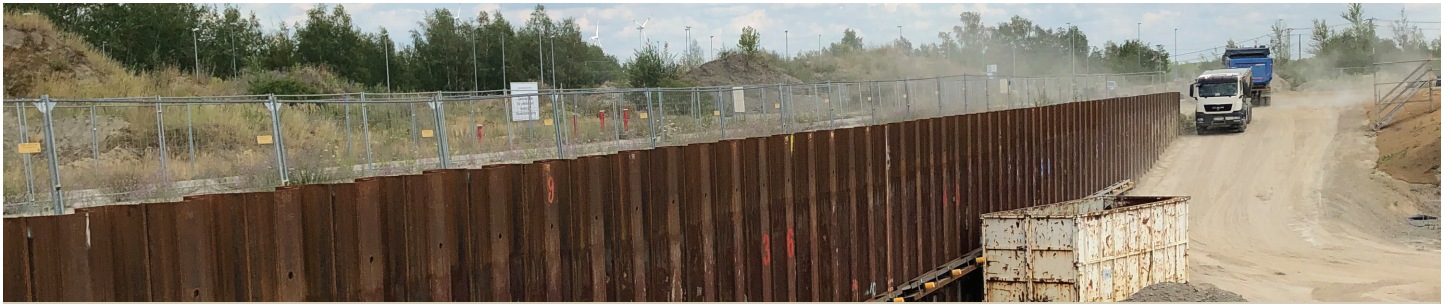
Rampe principale et rideau de palplanches ancré par l'arrière
