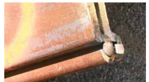
Boulon inséré dans la serrure à l'avancement
