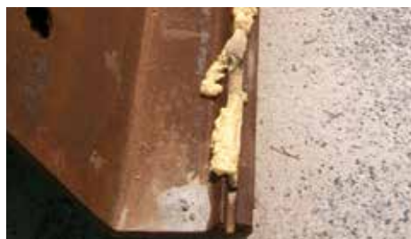
Comblement des serrures avec de la graisse ou du joint
