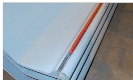
Extrudierte Dichtungslippen aus MSP-1 im Fädelschloß
