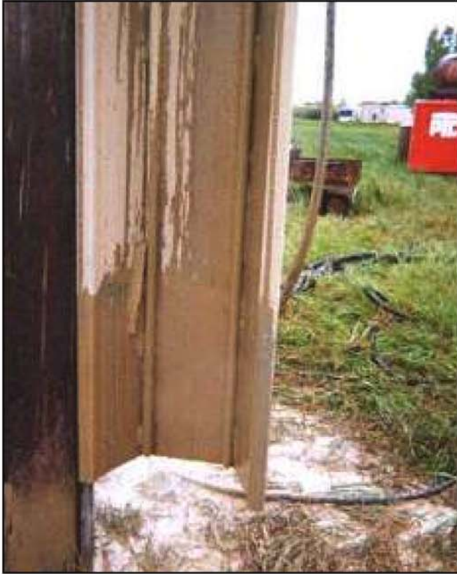
Photo 2 : arrachage d'une palplanche U après lancement.
