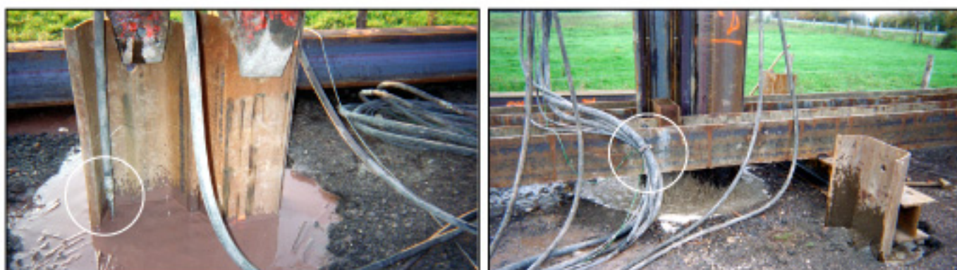
Vue des flexibles raccordés aux lances (ici en fin de fonçage)
