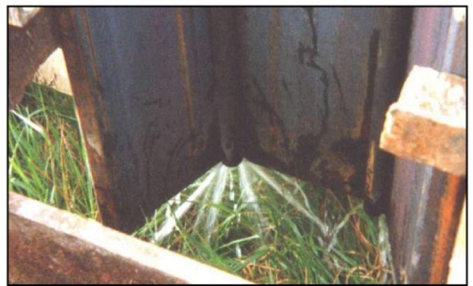
Photo 1 : pied de palplanche U avec deux lances en action.
