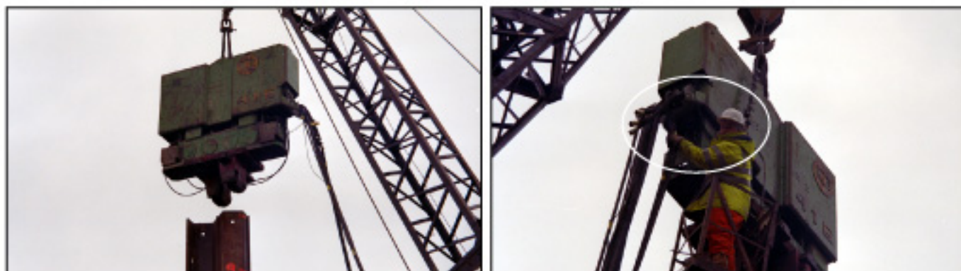
Opération de raccordement flexibles/lances
