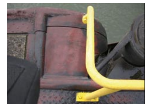
Draufsicht Schwimmpollernische mit Schwimmpoller, Schleuse Herne-Ost.
