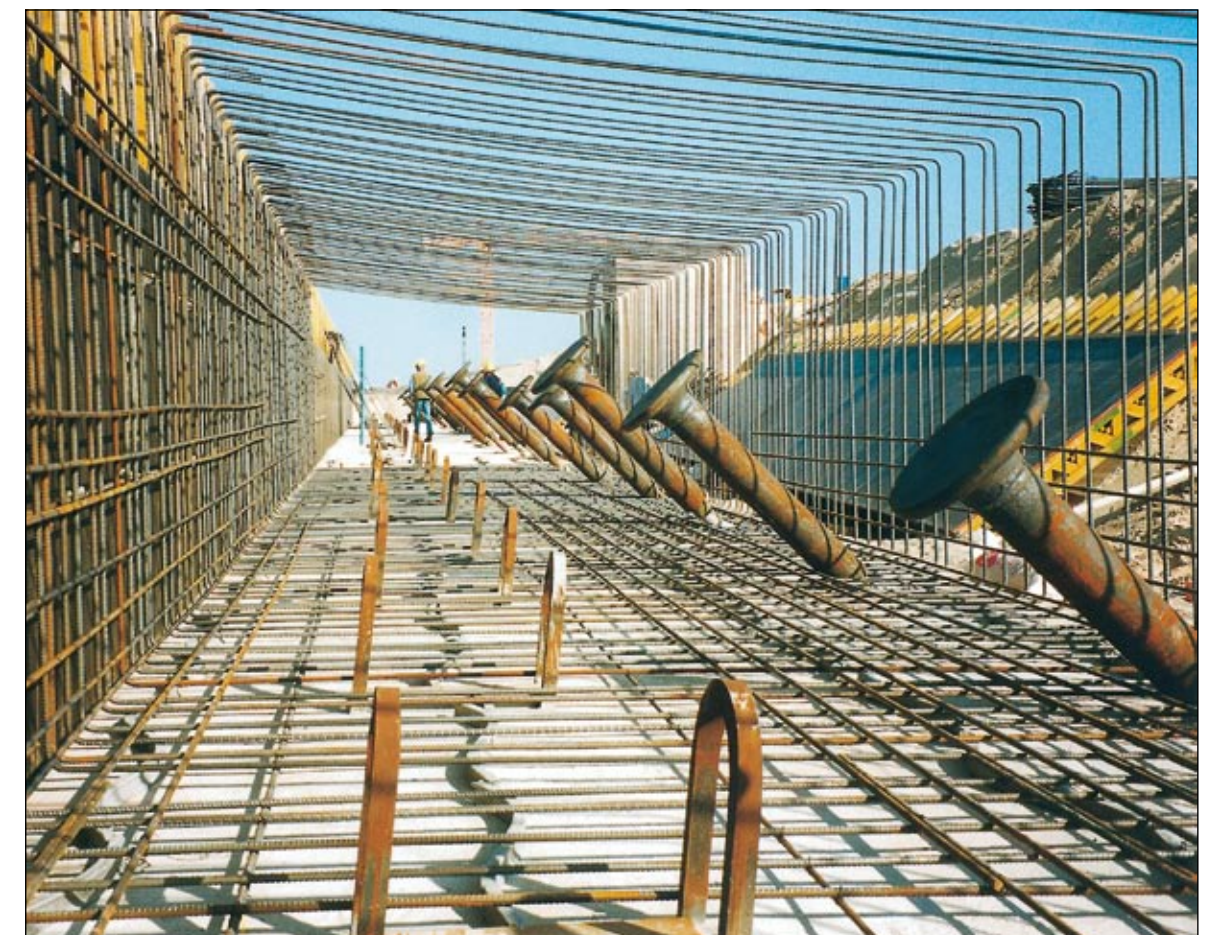
Telleranker Ø 180 mm / Ø 500 mm mit Innengewinde 5" für Container-Terminal Wilhelm Kaisen Bremerhaven Arge CT III
