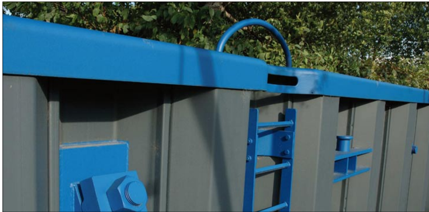
Spundwand mit Ausrüstungsmaterial Sheet piling with accessories
