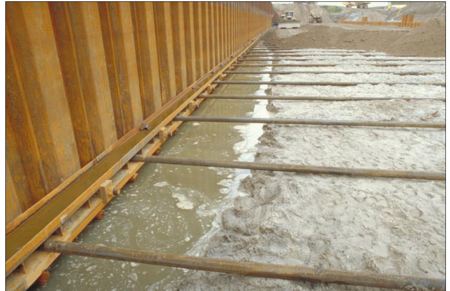
Verkehrsprojekte Deutsche Einheit Bau der Schleuse Rothensee
