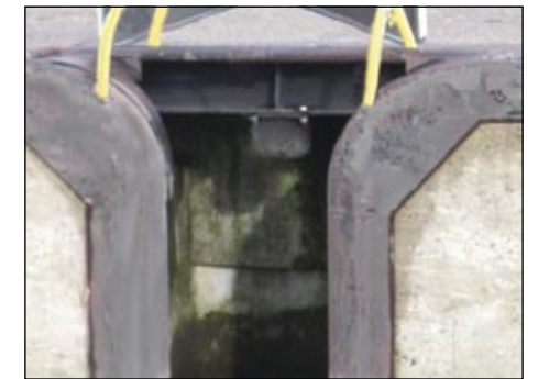
Ansicht Schwimmpollernischen mit Übergangsstücken (Guss) zum waagerechten Kantenschutz (auf Anfrage).
