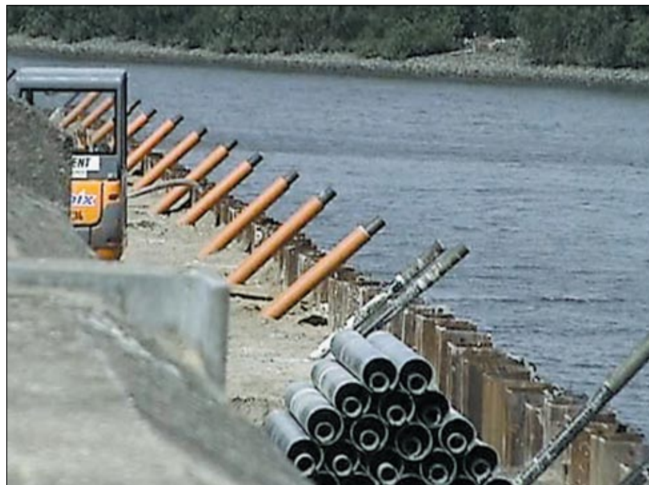
Gebohrte Ankerpfähle nach DIN 4128 vorbereitet zum Einbau in einen Stahlbetonholm. Stump, Hannover
