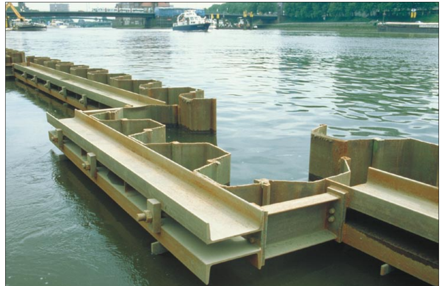
Gurtung mit Ausschnitt für Dalben Walings with cut-out for dolphins
