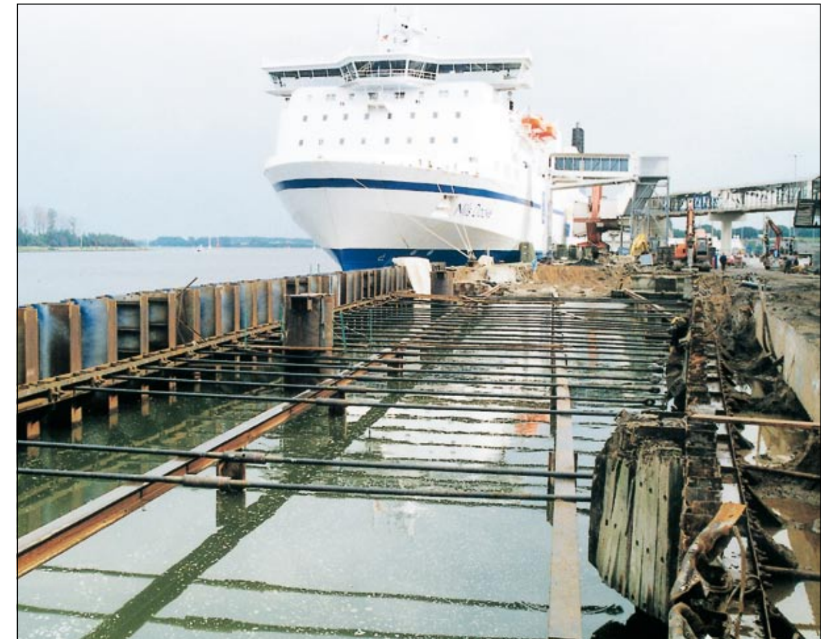
Liegeplatz 1-4 Lübeck- Travemünde TAGU; Nordenham
