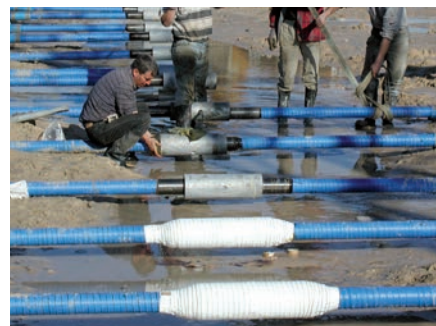
Cintas de protección de uniones in situ
