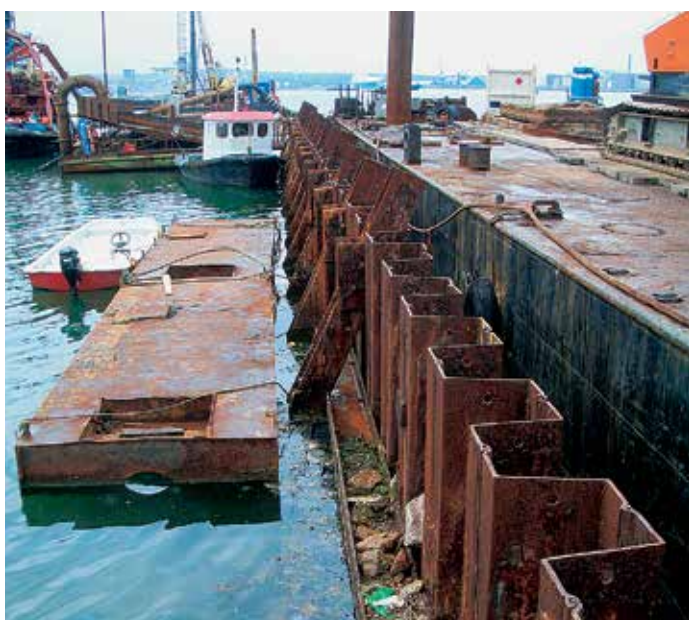
Новую причальную стенку временно подпирала наклонными сваями.
