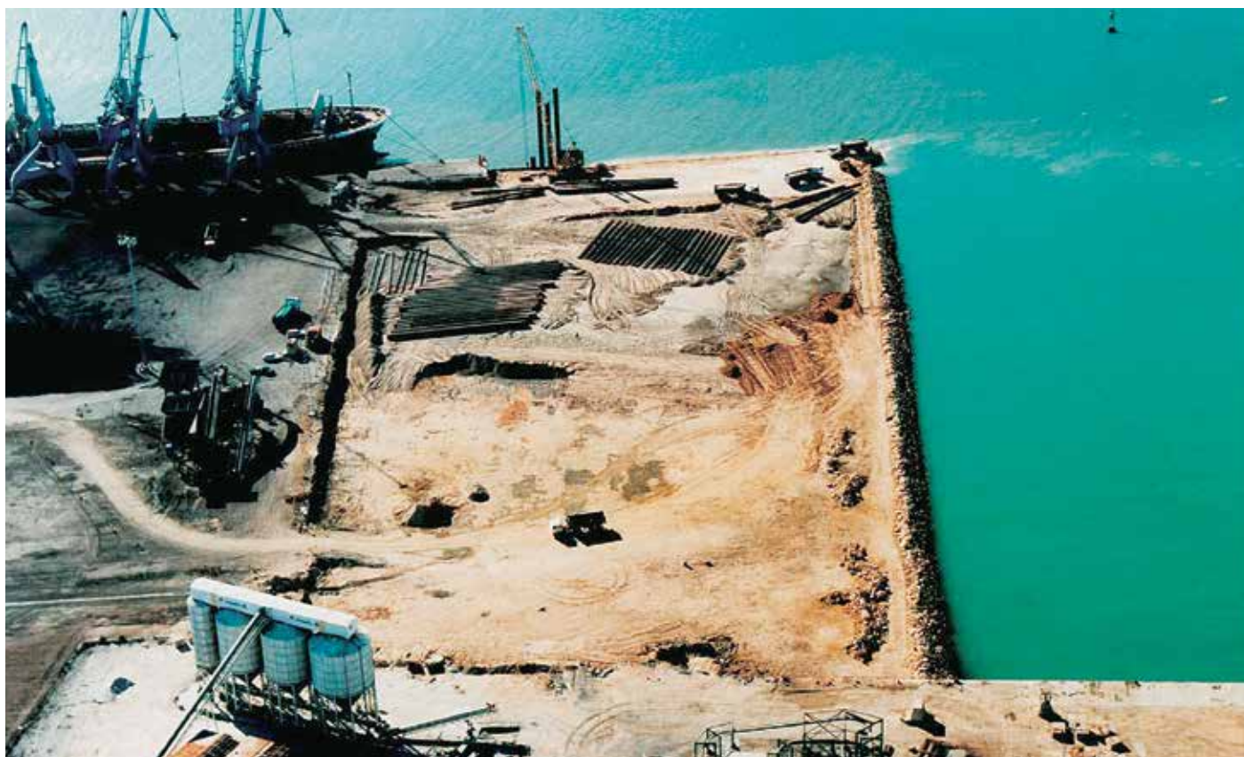
Был выбран вариант расширения бетонного причала за счет шпунтовых свай благодаря экономической выгоде при их использовании.
