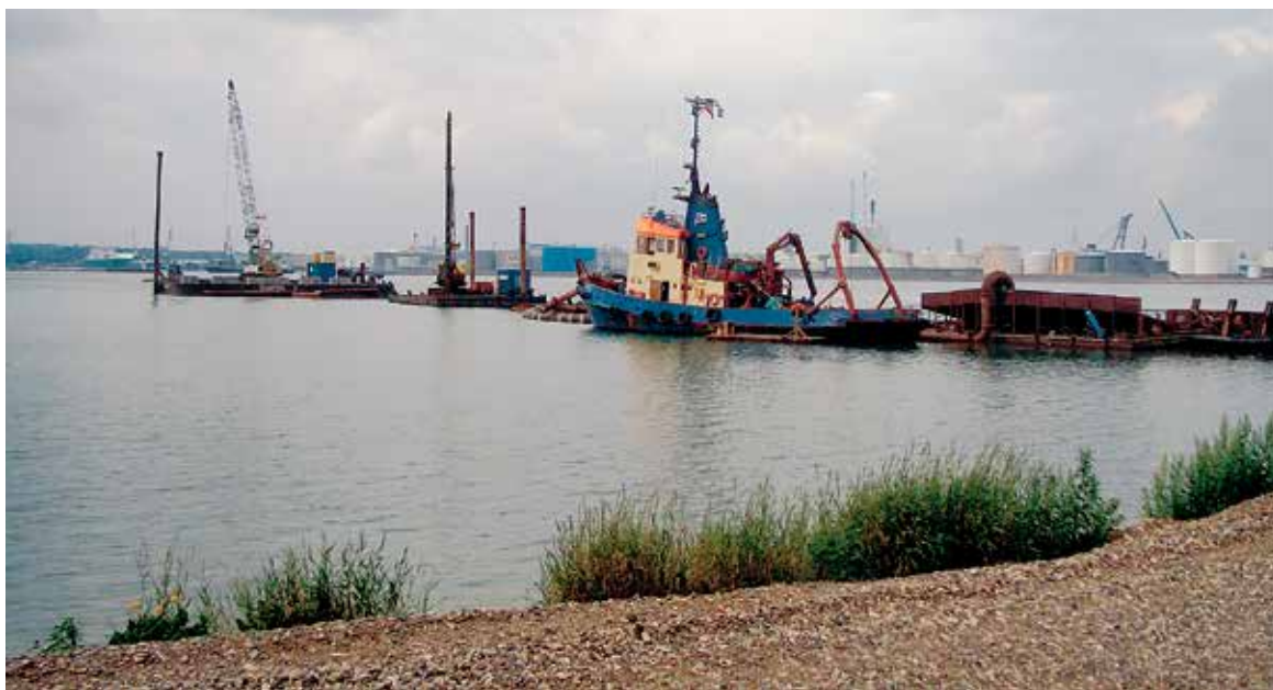
Строительное оборудование для сооружения причальной стенки разместили на баржах.
