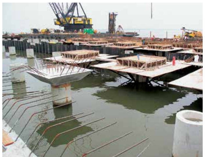
Опорные сваи фронтальной части нового Южного причала MTH.
