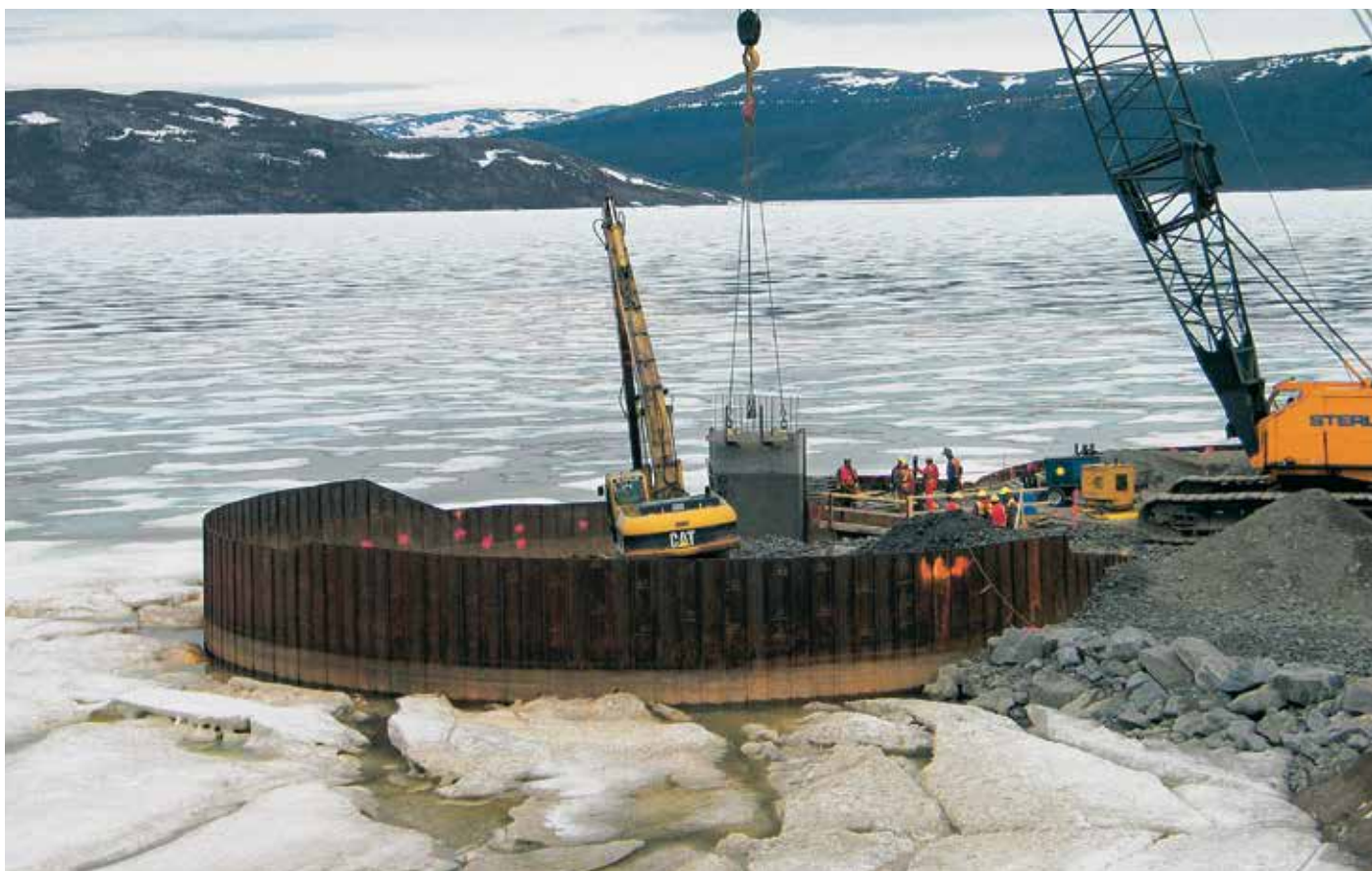
Проект ячеек большого диаметра из шпунтовых свай должен был учитывать нагрузки от давления льда.
