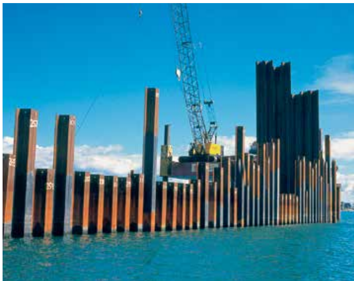
Исходя из расчетного срока эксплуатации сооружения 50 лет нанесли два слоя эпоксидного покрытия, не содержащего смол.
