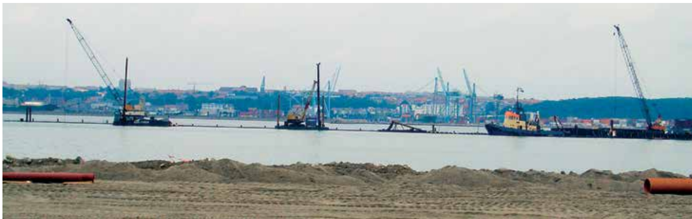
На сооружение лицевой причальной стенки протяженностью 1170 м пошло порядка 4000 тонн свай PU 32 разной длины.
