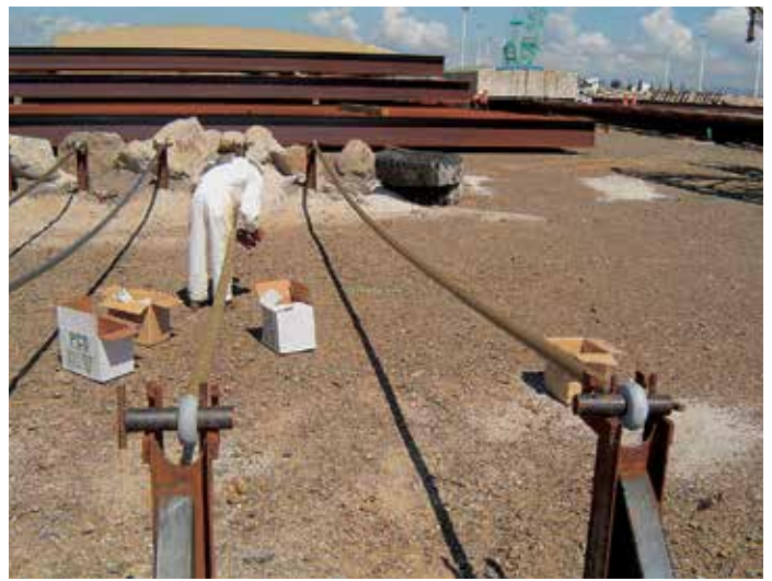
Анкерные тяги обернули противокоррозионной защитной лентой.
