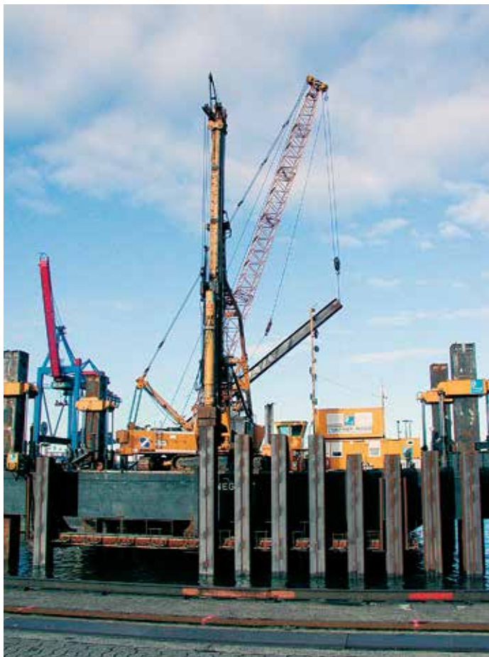
Подъем HZ-свай для их установки в направляющий кондуктор.
