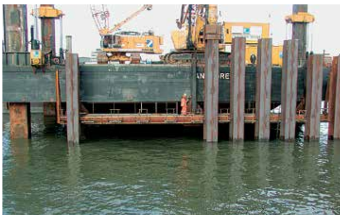
Направляющий кондуктор для сдвоенных HZ-свай.
