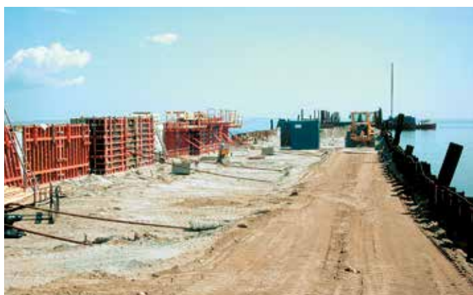
Опалубка для железобетонного оголовка.
