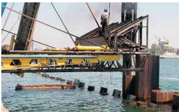
Кондуктор состоял из двух уровней направляющих из стальных труб, оборудованных резиновыми накладками.
