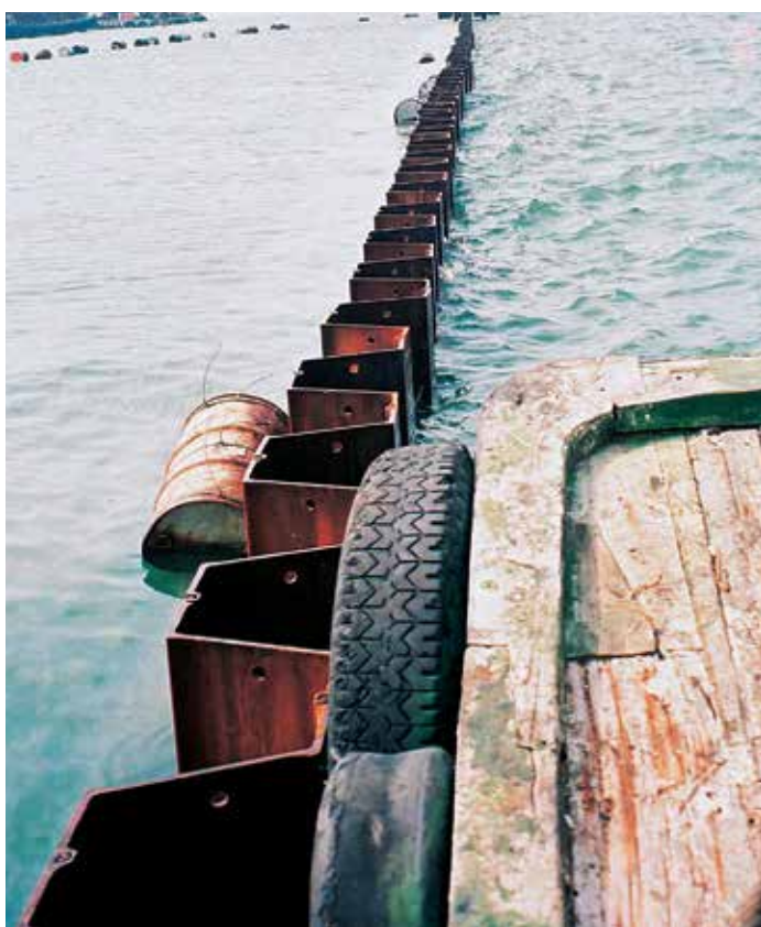
Визуальный контроль прямолинейности оси шпунтовой стенки.
