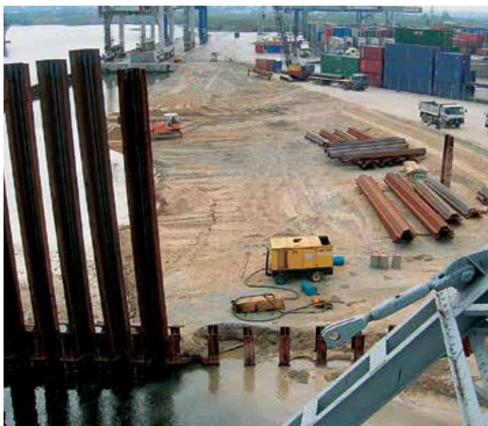
AZ-сваи вставляют между основными HZ-сваями, затем погружают до проектной глубины.
