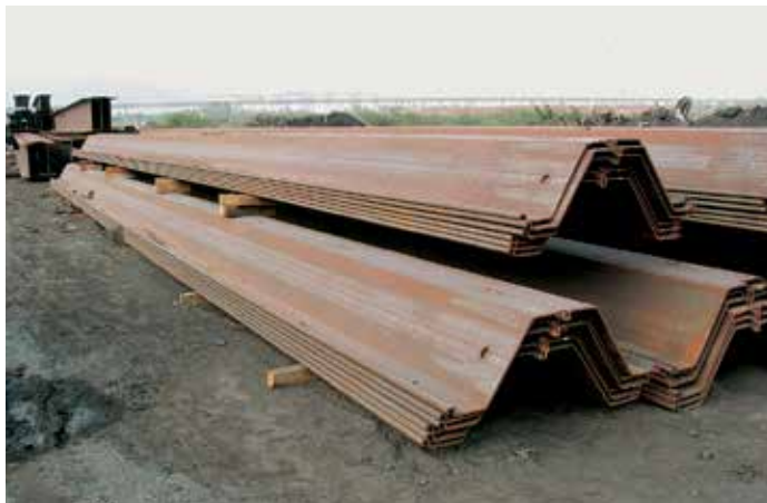
Складирование AZ-шпунта: дополнительная сепарация деревянными брусками предотвращает сваи от повреждений во время их складирования.
