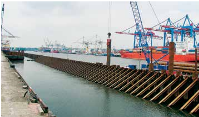
Новую шпунтовую стенку Причала 1 возвели перед старой причальной стенкой на расстоянии 36,9 м.
