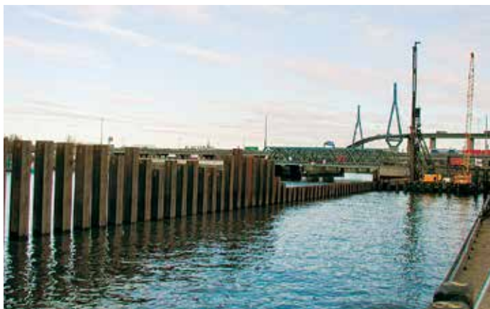
Погружение HZ-свай выполнялось с использованием двухуровневого кондуктора.
