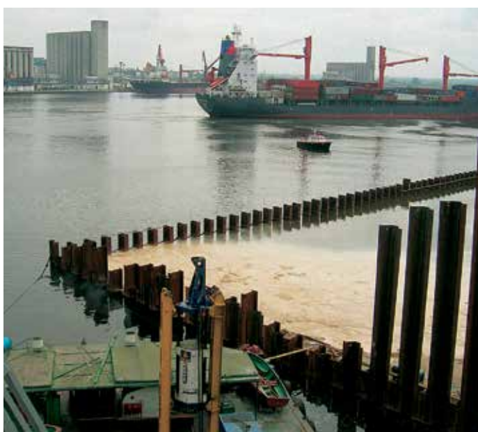
Область за причальной стенкой засыпали песком выемки при дноуглублении.
