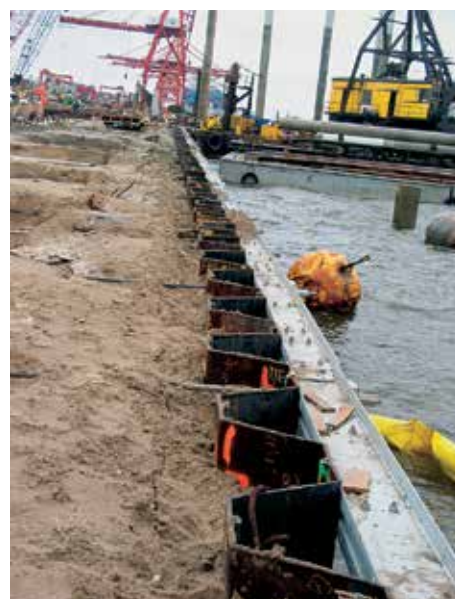
Распределительный пояс равномерно передает анкерные усилия на шпунтовую стенку.
