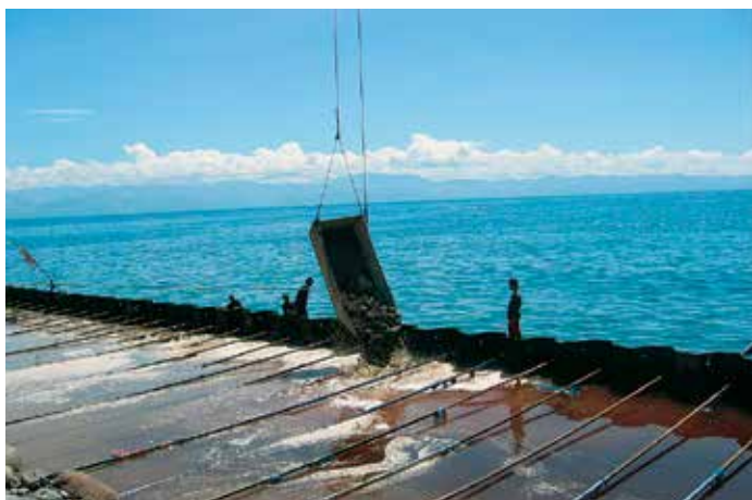
Отсыпку территории за шпунтовой стенкой производили с осторожностью, чтобы не допустить повреждения анкерных тяг.
