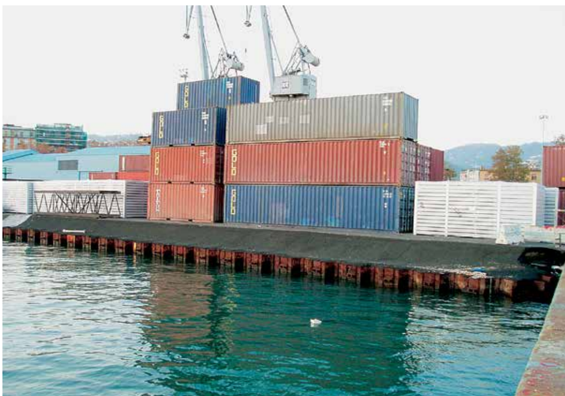
Благодаря использованию комбинированной системы HZ/AZ глубина нового причала достигает 10 м.
