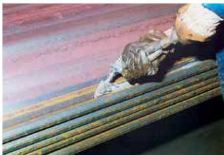
Заполнение в условиях цеха замковых соединений герметизирующей системой, расширяющейся при контакте с водой.
