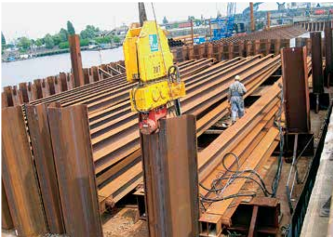
Установка вибропогружателя на «якорь» до установки грунтового анкера.
