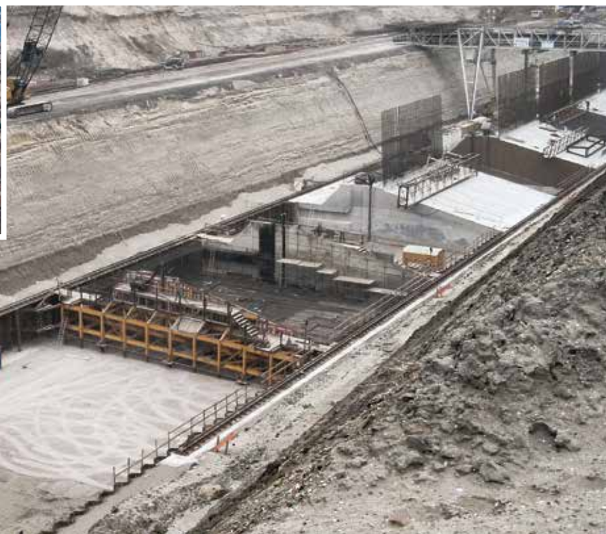
Свыше 6000 тонн стальных шпунтовых свай пошло на устройство шпунтовой стенки.
