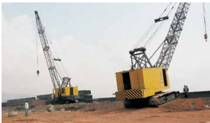
Для установки в проектное положение вибропогружателя и свай использовались два гусеничных крана.
