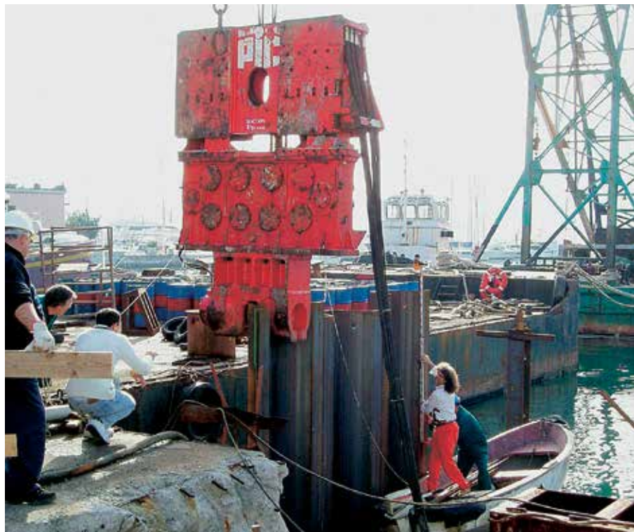
Погружение шпунта выполнено с использованием вибропогружателя РТС и направляющего кондуктора.
