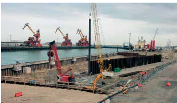
Причал 9: Демонтаж существующей анкерной стенки перед погружением свай новой стенки.
