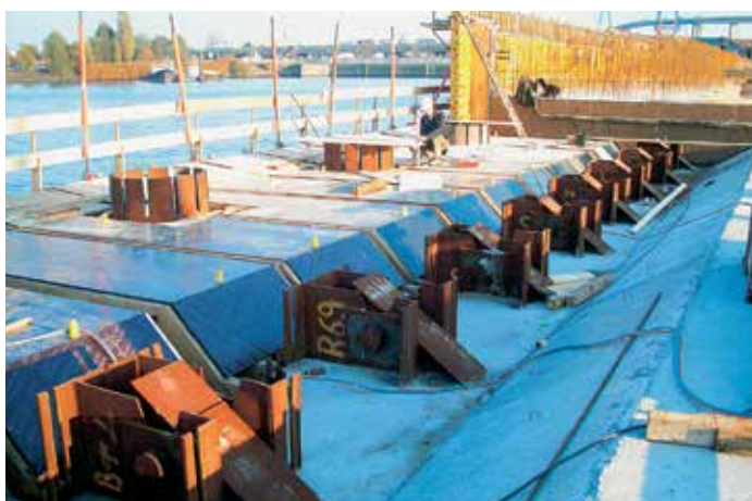
Разгрузочная бетонная плита верхнего строения, выполненная на отметке +3 м, позволила включить в проект более экономичные шпунтовые секции.
