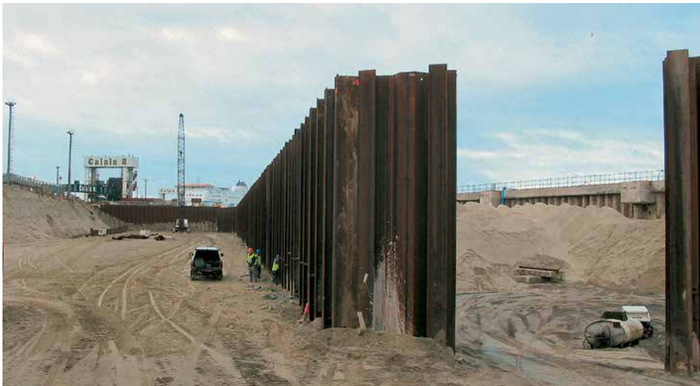
Грунтово-бentonитовая смесь засыпки предотвращает вымывание мелкозернистого песка через замковые соединения.
