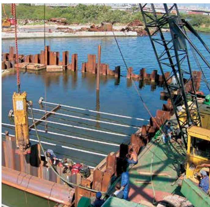
Забивка свай при помощи оборудования, установленного на барже.
