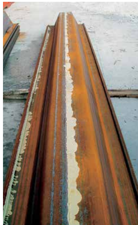
Замковые соединения свай были заполнены герметизирующим наполнителем Roxap, расширяющимся при контакте с водой.
