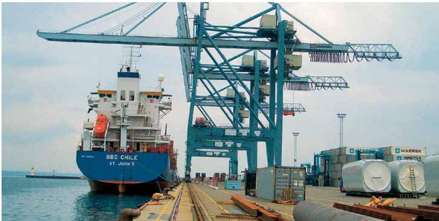
Участок действующего Восточного контейнерного терминала.
