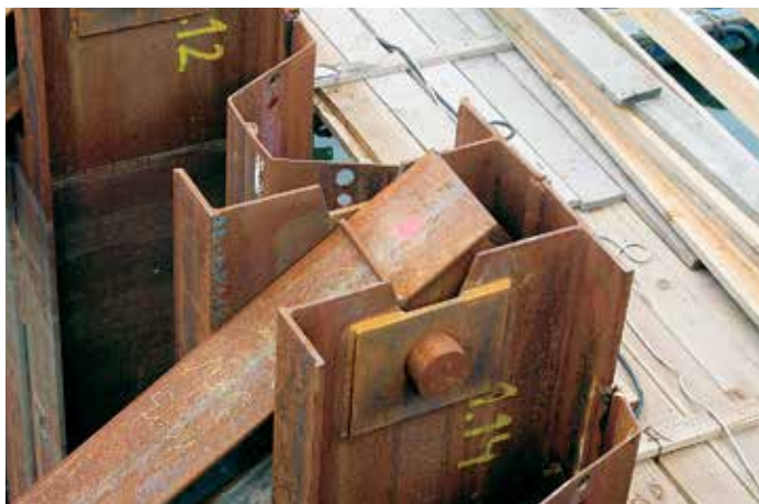
Шпилька диаметром 170 мм образует ось анкерной системы.
