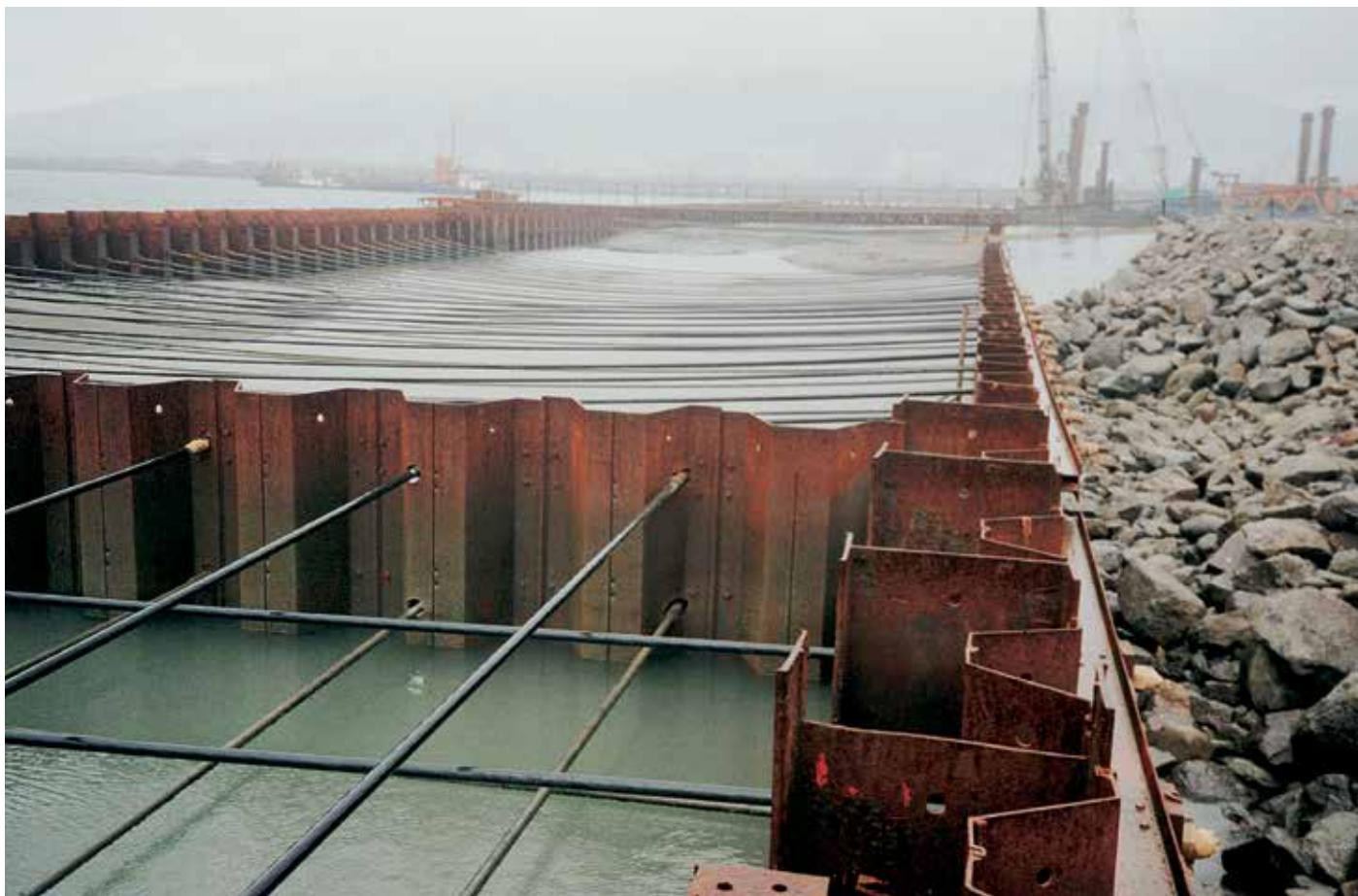
Пересечение рядов анкерных тяг, связывающих лицевую стенку и открылок с их анкерными стенками.
