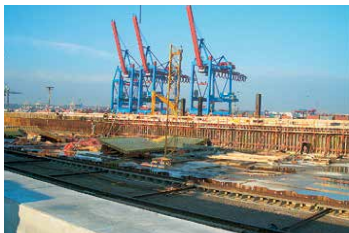
Разгрузочная бетонная плита верхнего строения, выполненная на отметке +3 м, позволила включить в проект более экономичные шпунтовые секции.
