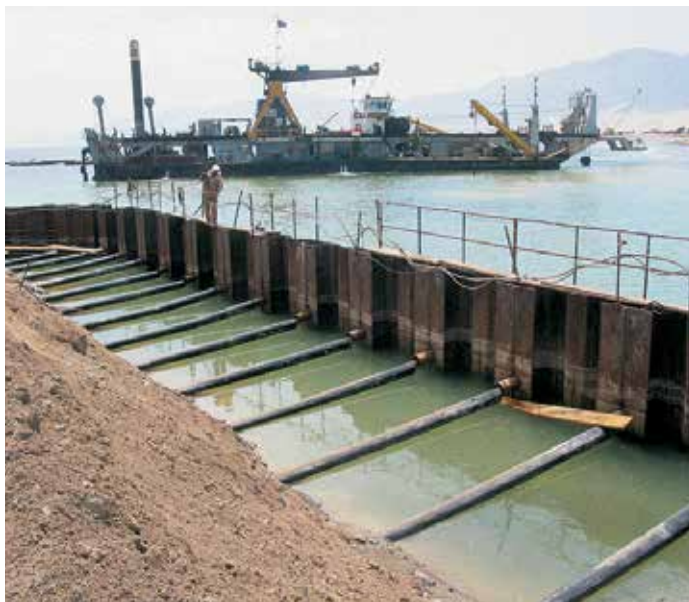
Оптимальным решением для причальной стенки была выбрана комбинированная HZ/AZ-система с анкерами.
