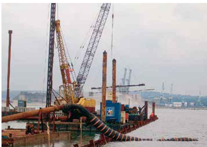
Кран поднимает анкерную тягу вместе с анкерными плитами для установки на глубине 11 метров.
