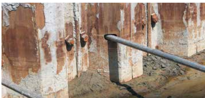
Узел соединения анкерных тяг и шпунтовой стенки.
