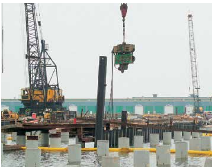
Погружение свай в гидроизоляционную стенку стока.
