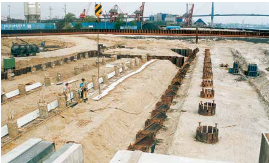
Устройство плиты разгрузочной эстакады поверх лицевой и задней шпунтовых стенок, стальных свай, работающих на растяжение, труб отбойников и бетонных свай.
