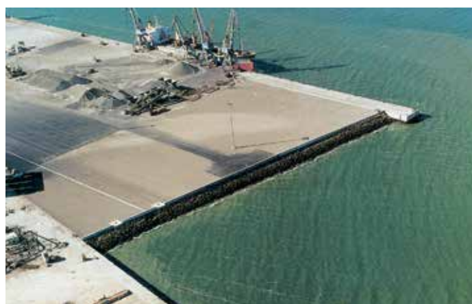
На расширение причала пошло 1600 тонн шпунтовых свай.
