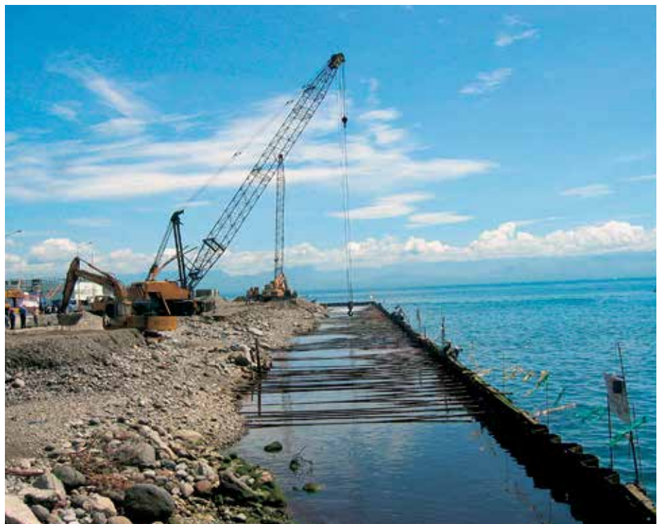
Для сооружения новых причальных стенок потребовалось 485 комплектов анкерных тяг из высокопрочной стали.
