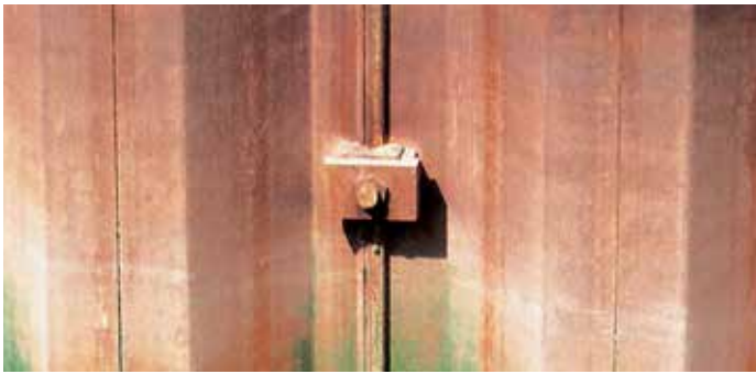
Место соединения анкерной тяги и сваи AZ 17.
