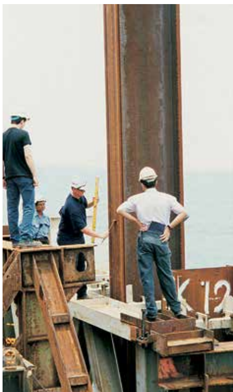
Для проведения консультаций на этапе погружения свай ArcelorMittal направил двух своих инженеров.
