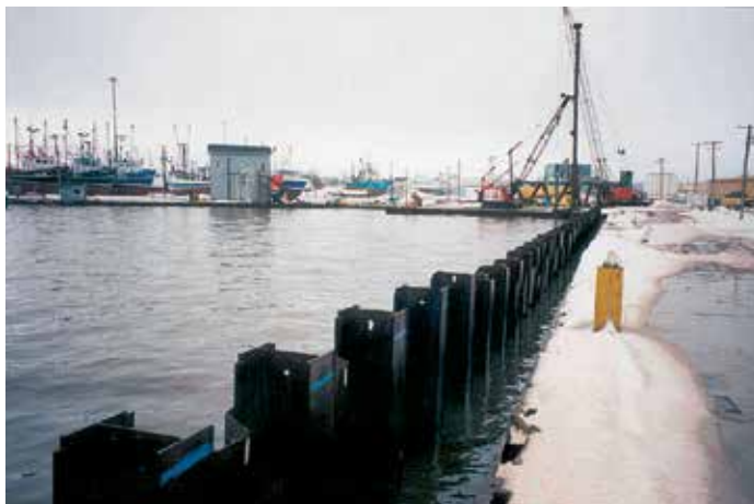
Новая шпунтовая стенка, установленная в 1,5 метрах перед уже существовавшей.
