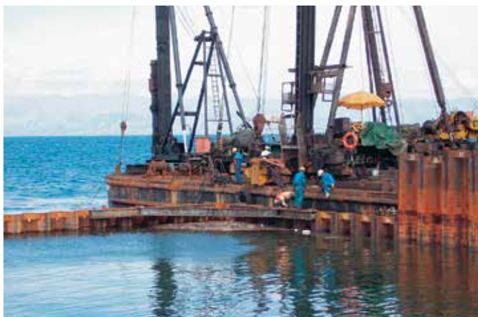
Двойные AZ-сваи AZ длиной до 21,5 м погружали с помощью оборудования, размещенного на барже.
