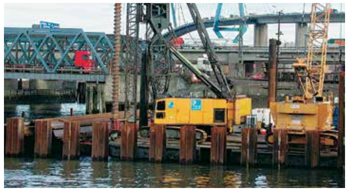
В силу крайне сложных грунтовых условий было принято решение о предварительном бурении для того, чтобы облегчить установку AZ-свай.
