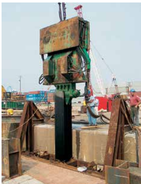
Забивка основных свай при помощи двухуровневого кондуктора.
