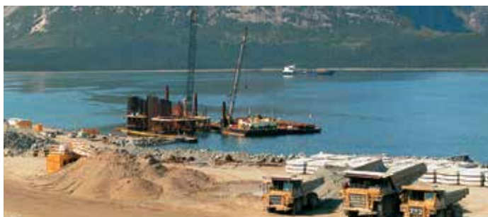
Сваи погружали с помощью оборудования, размещенного на барже.
