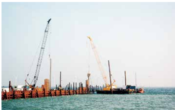
Строительство взаимозаанкеренного коффердама на территории открытой акватории.
