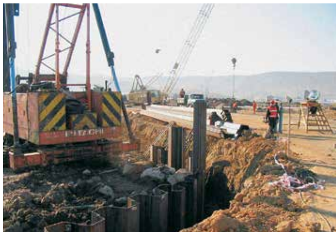
На строительство сухого дока для сооружения морских платформ потребовалось более 3000 тонн стальных шпунтовых свай.
