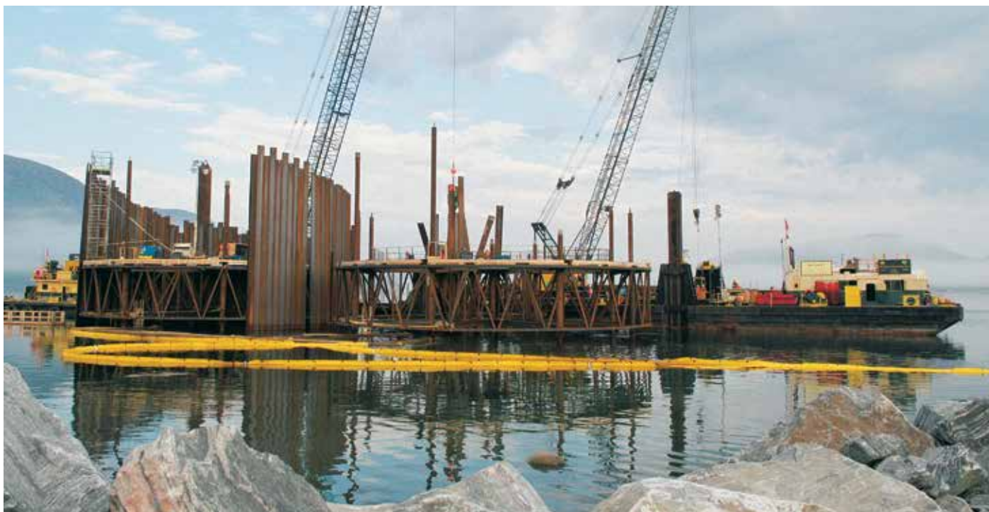
Шпунтовые сваи погружались с помощью направляющего кондуктора.
