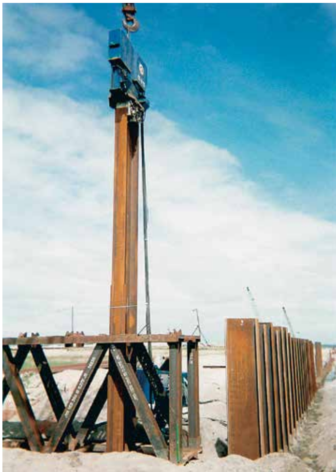
Двухуровневый кондуктор обеспечивал прямолинейность при погружении HZ-свай.
