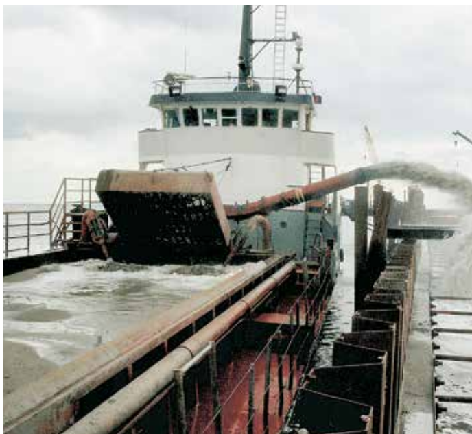
Отсыпка коффердама намытым песком.
