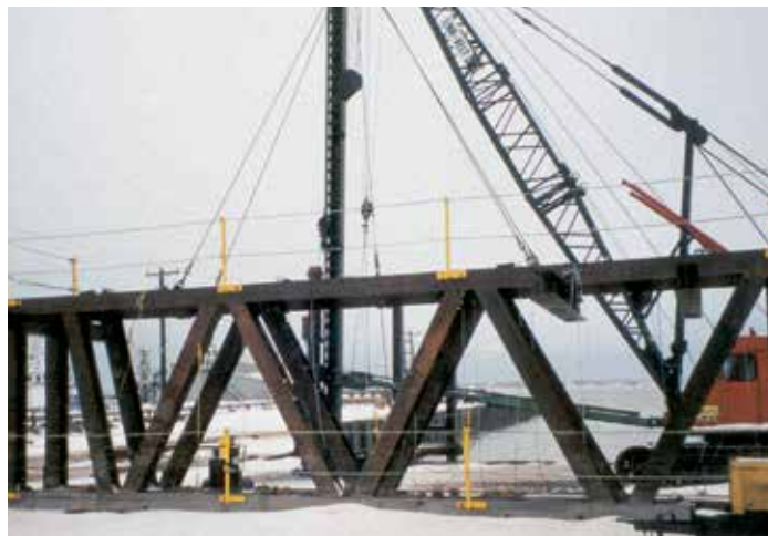
Двухуровневый кондуктор обеспечивает корректное позиционирование основных (несущих) HZ-свай для забивки.
