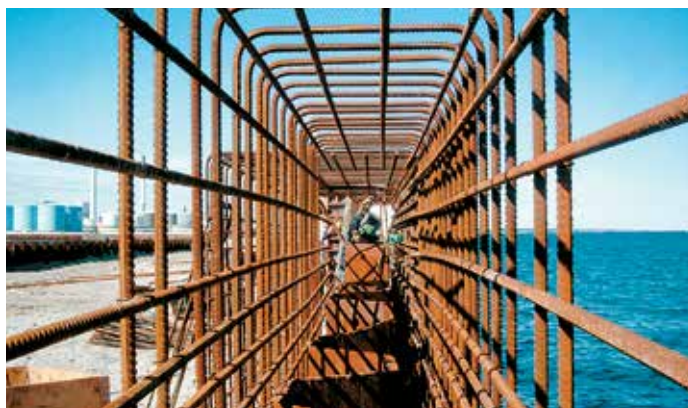
Армокаркас железобетонного оголовка.
