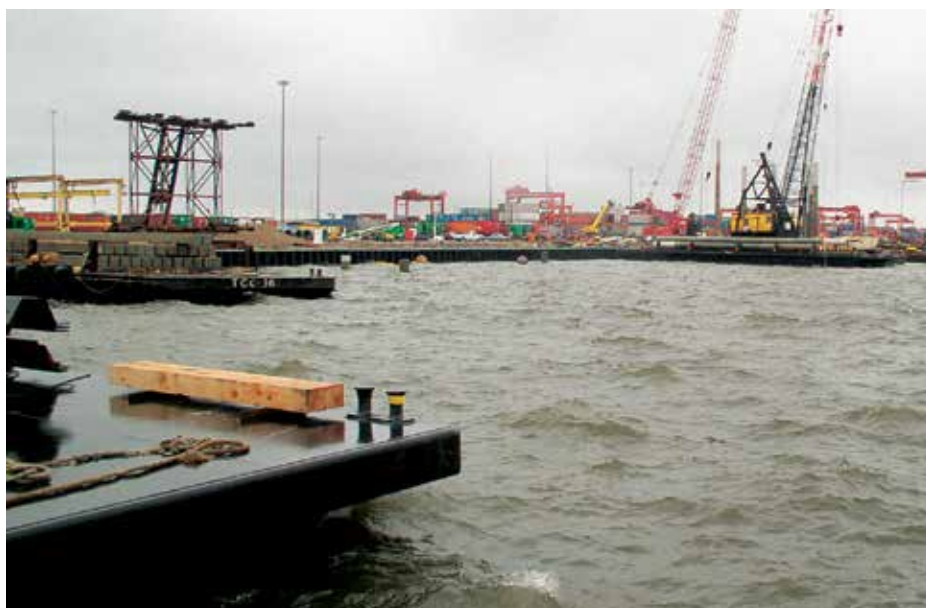
Вид на строительную площадку
