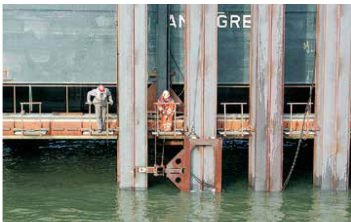
Скользкий направляющий механизм типа «салазки», установленный на нижний конец HZ-свай.
