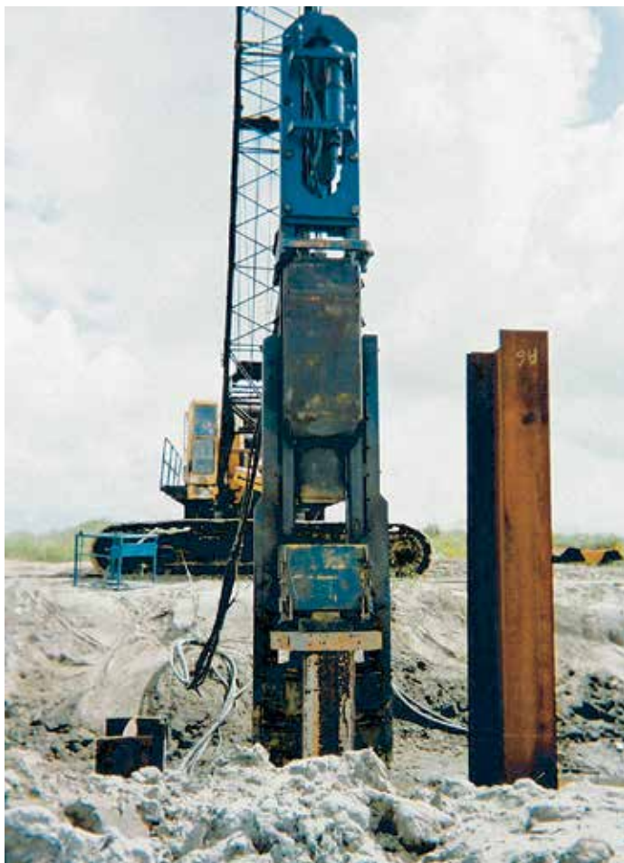
Благодаря кондуктору AZ-сваи точно входят в промежутки между основными HZ-сваями.
