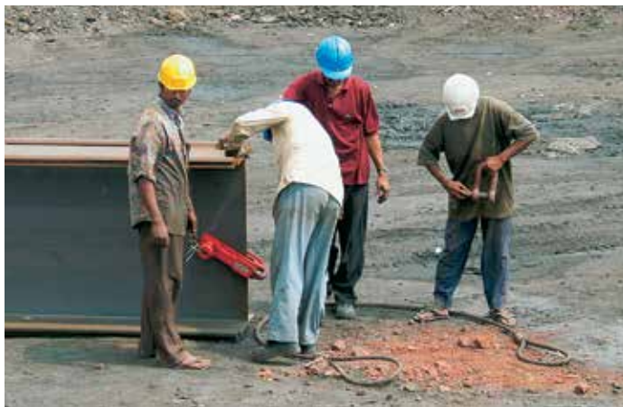
Для подъема основных свай использовались мощные захваты.
