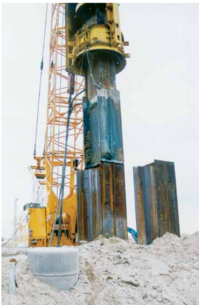
Тяжеловесные шпунтовые сборные элементы забивали на глубину 30,5 м с помощью ударного молота.
