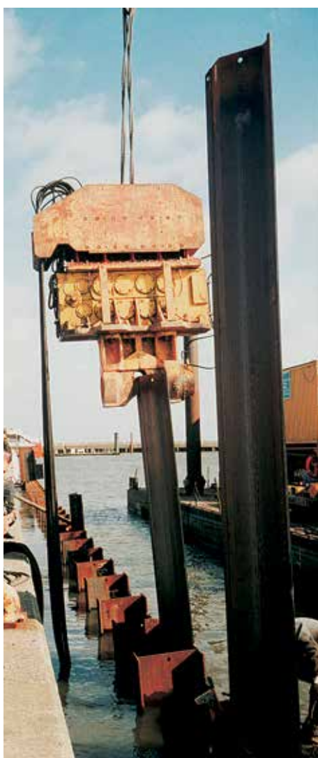
Вибропогружатель идеально подходил для установки промежуточных AZ-свай.
