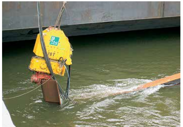
Установка анкерной системы с помощью вибропогружателя.
