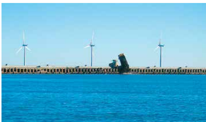
Сооружение также служит ограждением для отсыпки загрязненного грунта.
