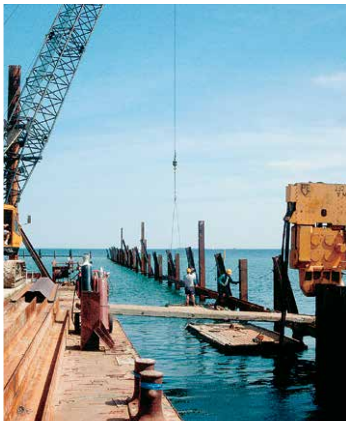
Кран, вибропогружатель и шпунтовые сваи грузили на баржу.
