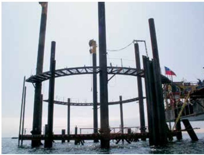
Волнолом состоит из восьми ячеек диаметром 24 м.
