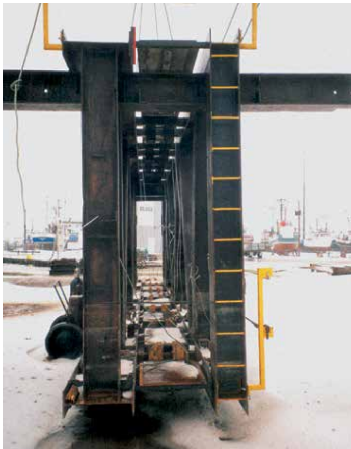
Направляющий кондуктор – Восемь направляющих рам – по четыре на каждый уровень шаблона, направляют каждую основную HZ-сваю.
