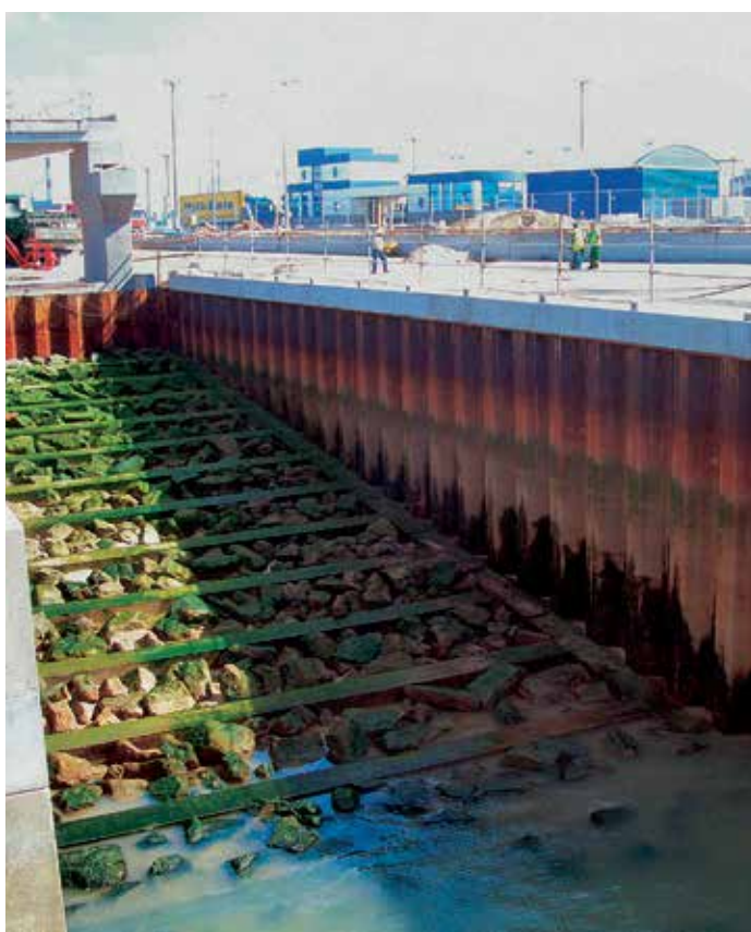
Нижняя рампа, устроенная в нише размером 35 x 14 м из шпунтовых свай.
