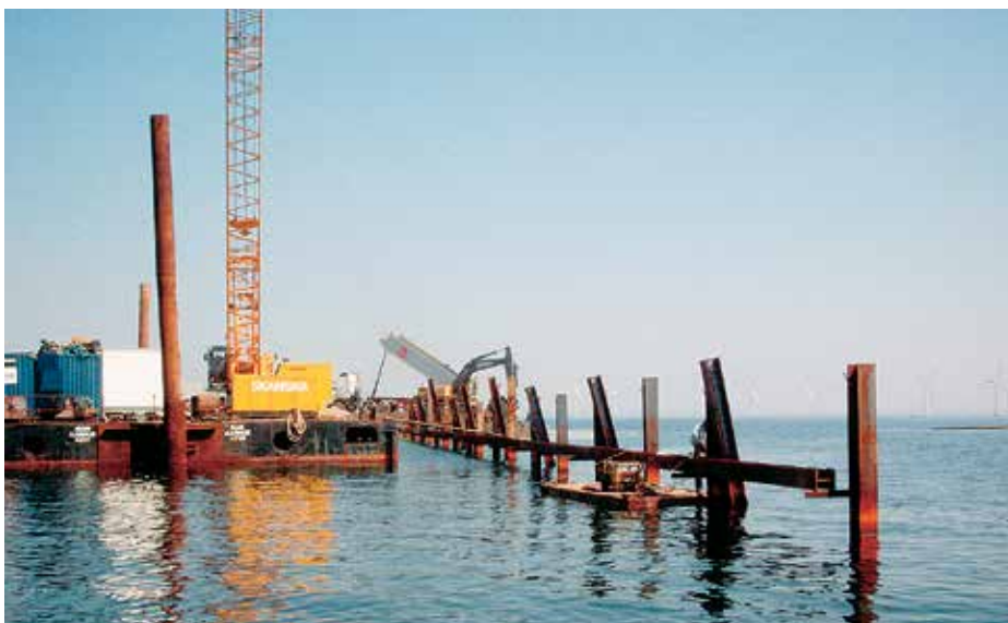
В качестве кондуктора для погружения использовали горизонтальные балки.
