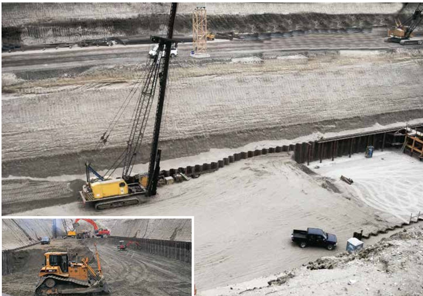
Погружение AZ-свай AZ с помощью дизельного ударного молота.
