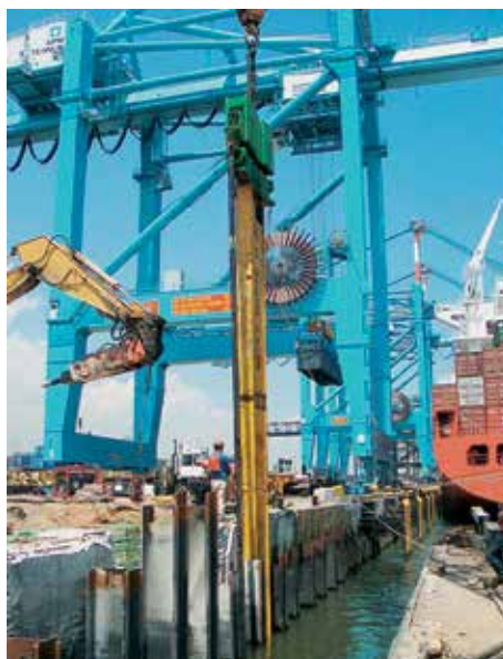
Специальная балка передавала усилие при вибропогружении на промежуточные «подводные» AZ-сваи.
