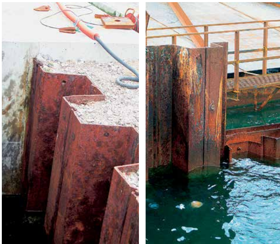
Узел А: Конец бетонного оголовка старого Восточного контейнерного терминала. Существующие шпунтовые сваи Восточного контейнерного терминала установлены еще на несколько метров после бетонного оголовка.
