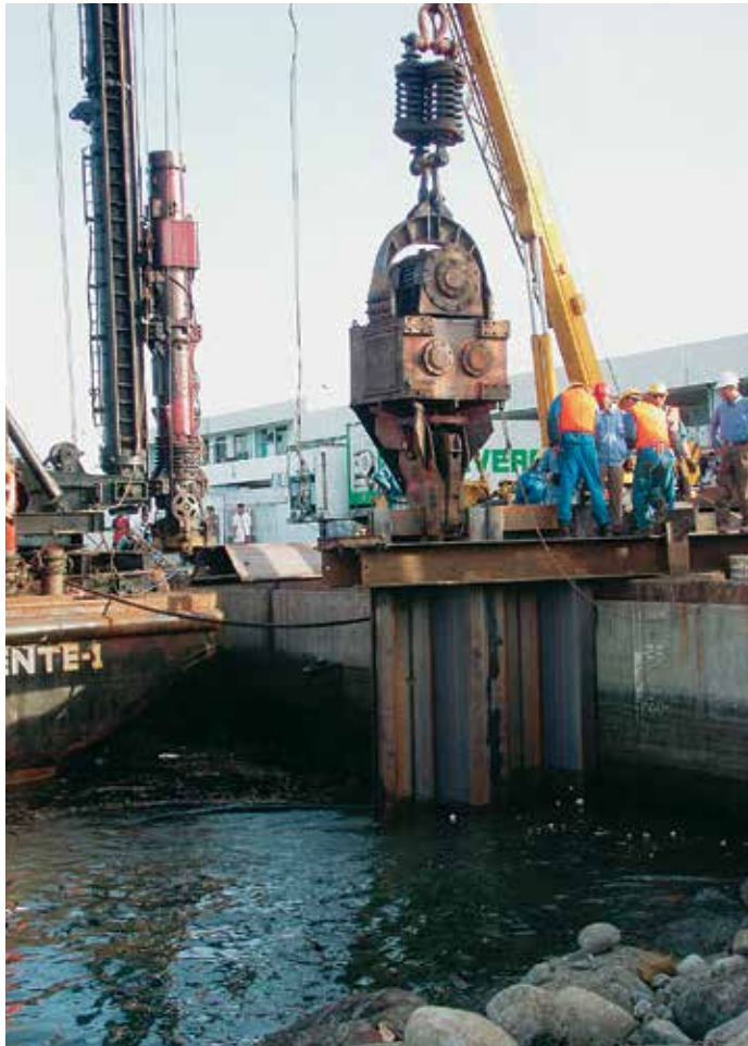
На начальном этапе установки свай использовался вибропогружатель, дизельный молот завершал процесс.
