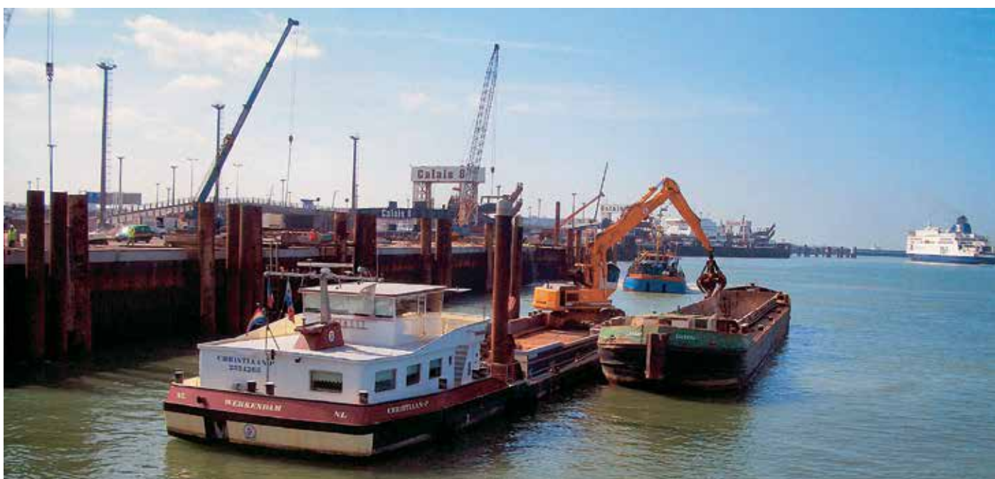
Удаление установленном на барже краном скальной породы со дна существующего причала.
