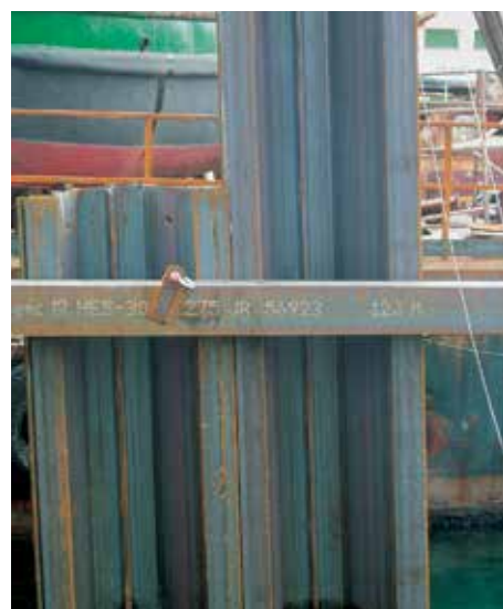
Новый пирс протяженностью 400 м будет завершен к 2006 году с использованием шпунтовых свай типа AZ 36 и AZ 18.
