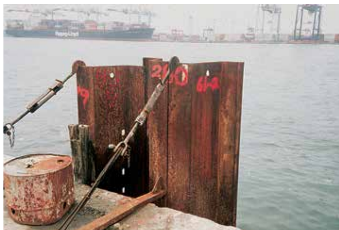
Сваи забивали вдоль стенки существующего причала.
