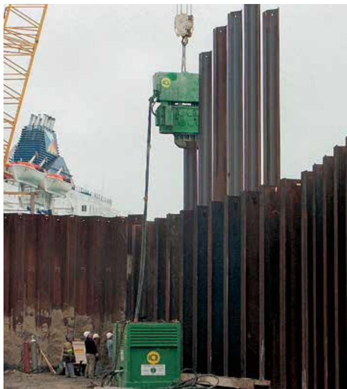
Вибропогружение промежуточных свай типа AZ 12 длиной 21,6 м.
