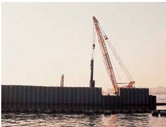
Погружение шпунтовых свай на открытой воде с помощью вибропогружателя и ударного молота, размещенных на барже.
