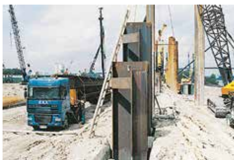
Вследствие непростых грунтовых условий и с целью снижения уровня вибрации шпунтовые сваи погружали в выложенной бентонитом траншее.
