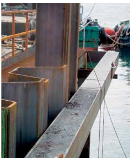
Установка шпунтовых свай типа AZ с помощью кондуктора.
