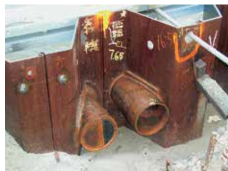
В шпунтовых сваях подготавливали отверстия, для пропуска анкерных тяг.
