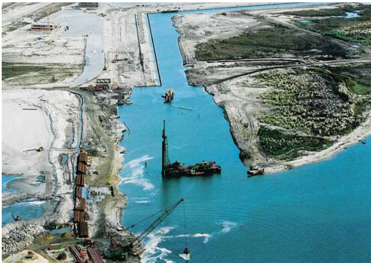
Два участка нового терминала в Авейру с суммарной протяженностью шпунтовой стенки 750 м.
