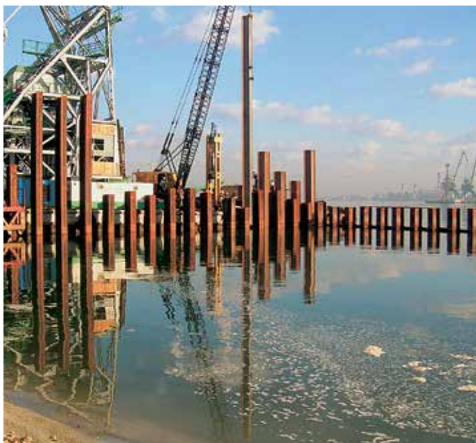
Забивка несущих HZ-свай на углу L-образной стенки.
