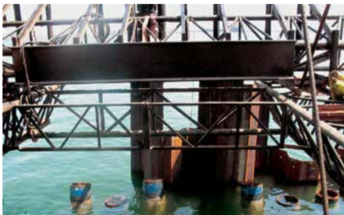
Вертикальные и наклонные сваи также устанавливали с помощью направляющего кондуктора.
