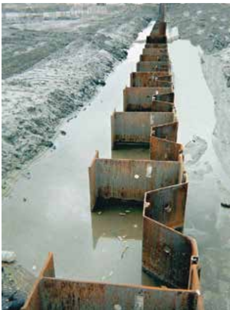
Верх шпунтовой стенки впоследствии был закрыт бетонным оголовком.
