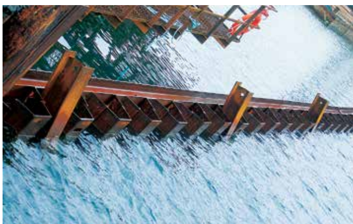
В качестве распределительного пояса использовалась стальная балка.
