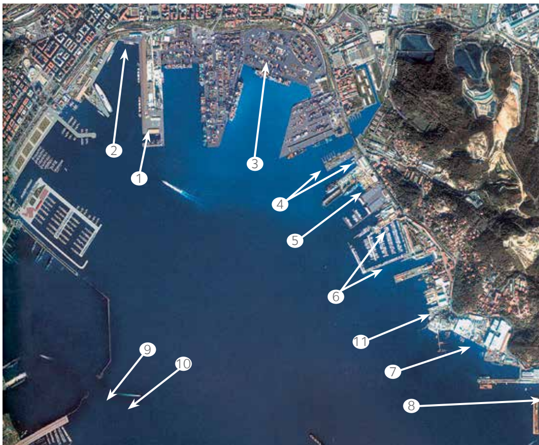
На 11 проектах в Специи использовали 27.500 тонн стальных шпунтовых свай.
