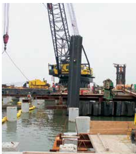
Кондуктор обеспечивает прямолинейность шпунтовой стенки.
