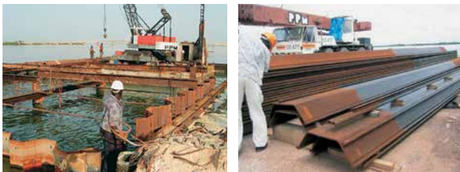
Для увеличения срока службы материалов использовали трёхслойное защитное покрытие.
