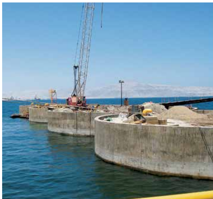
Бетонные оголовки защищают головы шпунтовых ячеек.
