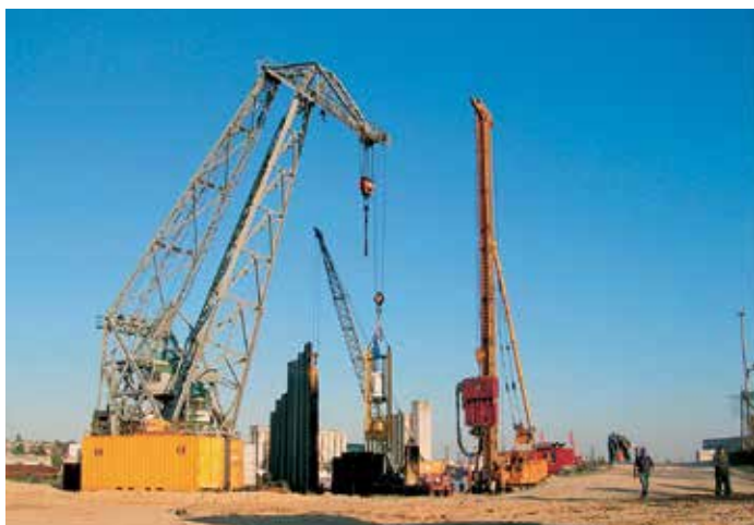
HZ-сваи погружали до отказа сначала вибропогружателем, а затем молотом забивали до проектной глубины.
