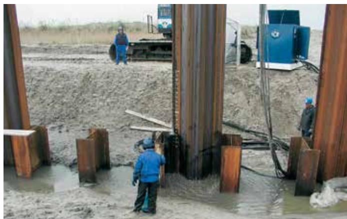
Шпунт погружали вибропогружателем до отказа.
