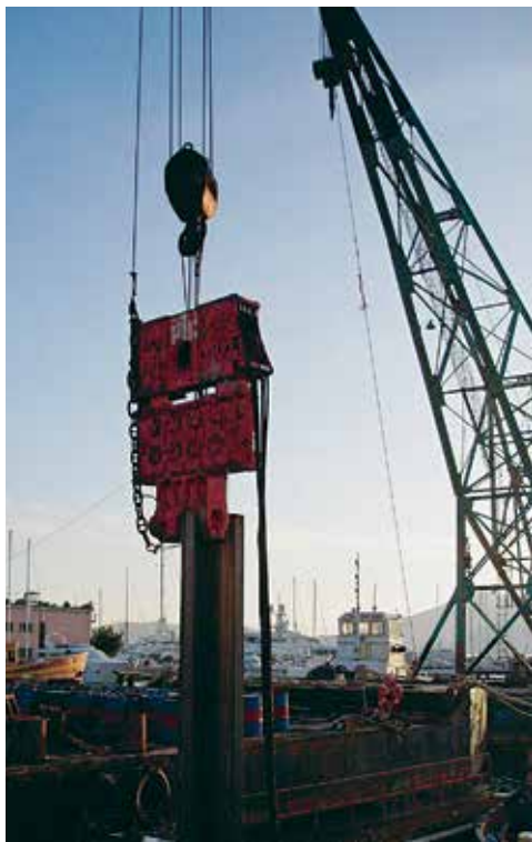
Погружение шпунта выполнено с использованием вибропогружателя РТС и направляющего кондуктора.
