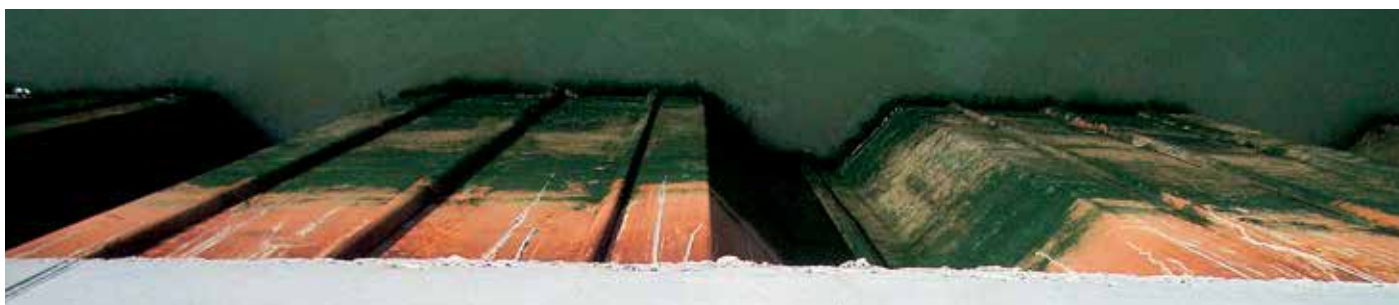
Система HZ 775 C-26 / AZ 12: глубина причальной стенки достигает 8,5 м.
