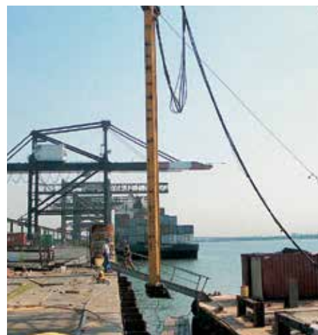
Оборудование для погружения в воду не опускалось.
