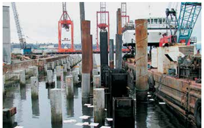
Установка шпунтовой стенки, обеспечивающей устойчивость конструкции, производилась с баржи.
