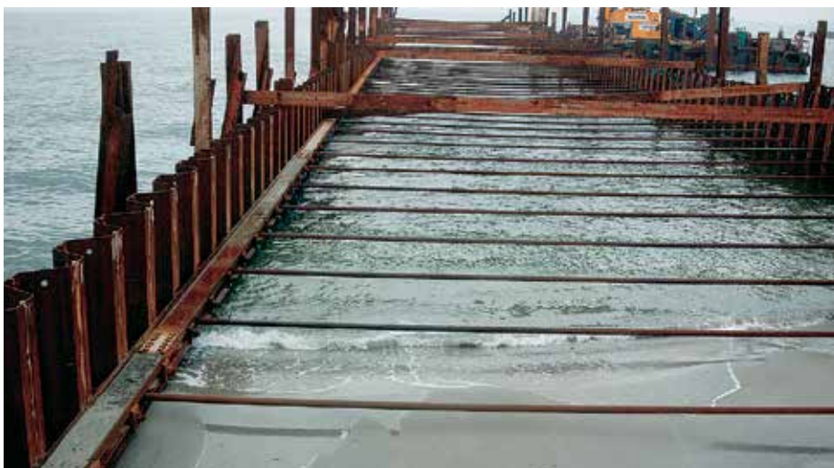
Верхний уровень стальных анкерных тяг внутри коффердама.
