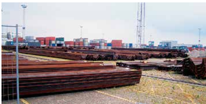
Складирование шпунтовых свай.
