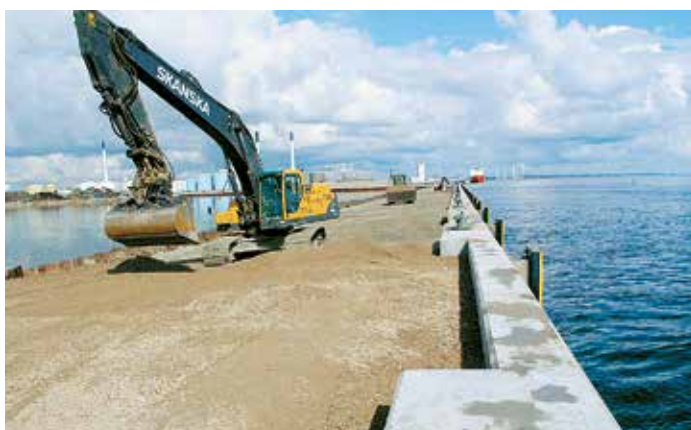
Для завершения сооружения поверху шпунтовой стенки возвели железобетонный оголовок с отбойниками и причальными тумбами.
