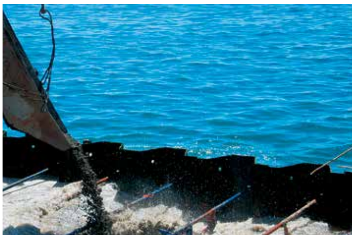
Отсыпку территории за шпунтовой стенкой производили с осторожностью, чтобы не допустить повреждения анкерных тяг.
