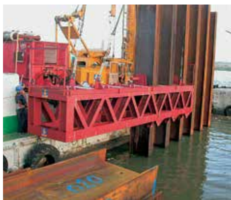
Точность установки основных HZ-свай контролировалась с помощью двухуровневого кондуктора
