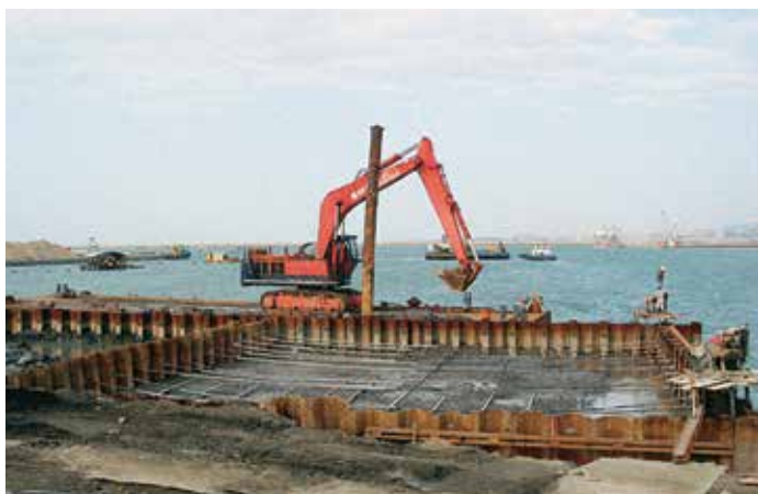
Отсыпку области между лицевой и анкерной стенками производил большой экскаватор.
