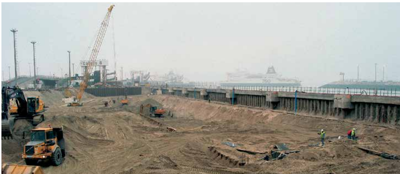
Благодаря существующей причальной стенке из шпунта типа PU 25 погружение новой стенки происходило с суши
