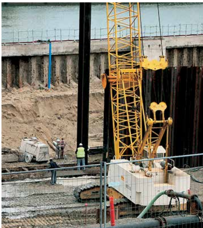
Погружение шпунтовых свай в бентонитовую траншею (стена в грунте) с использованием простого кондуктора.
