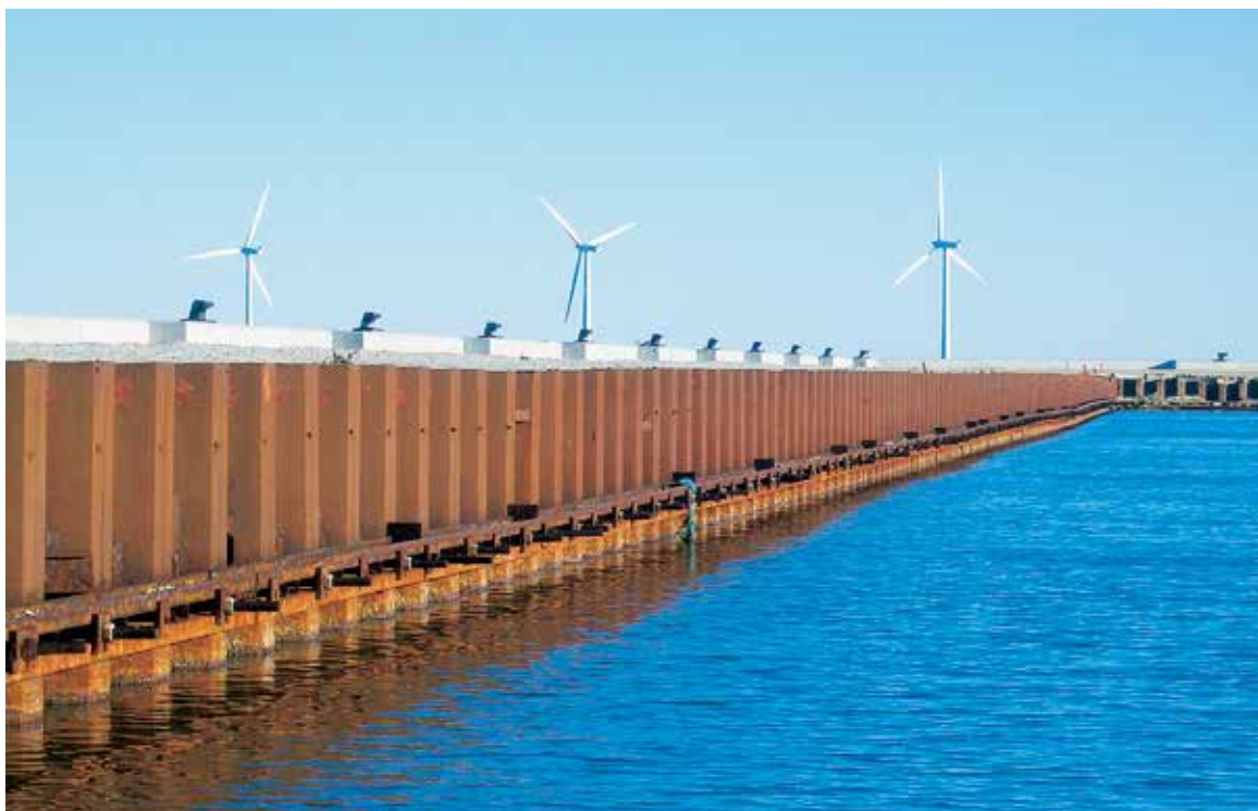
Котффердам из шпунтовых свай, служащий непроницаемым барьером для загрязненного грунта.
