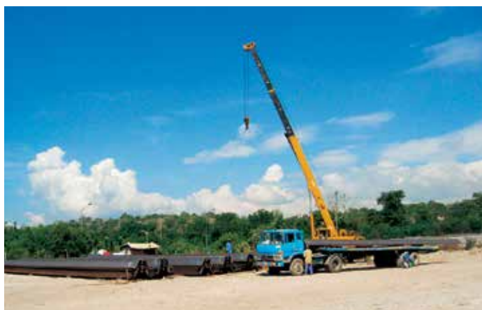
Все шпунтовые сваи были отправлены одной партией на объект, где их разгрузили и складировали.
