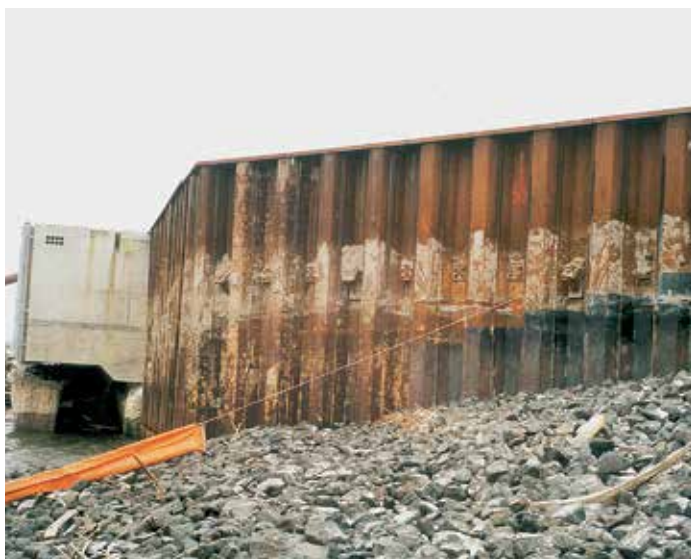
Строение с обеих сторон завершается шпунтовой стенкой.
