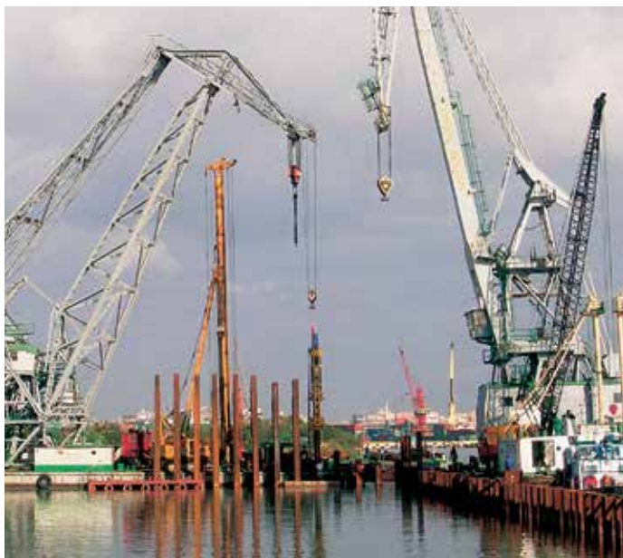
При установке комбинированной шпунтовой стенки использовался арендованный на месте плавучий кран.
