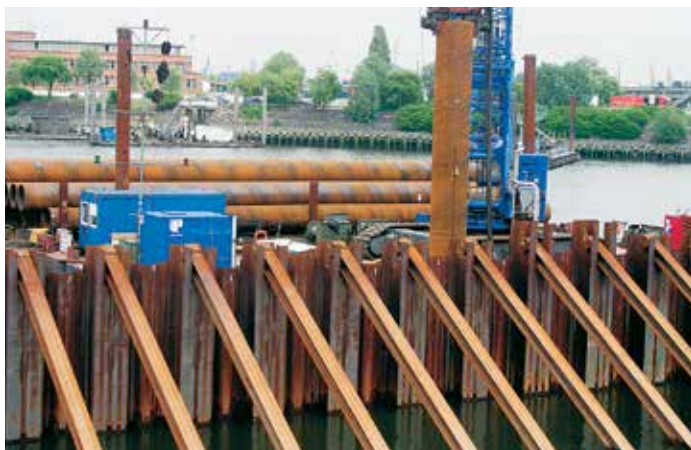
Стальные трубчатые сваи для восприятия вертикальных нагрузок и защиты от размыва грунта у причальной стенки.
