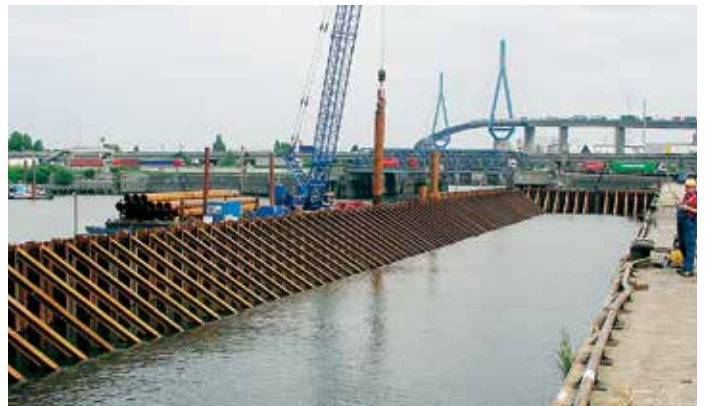
Новую шпунтовую стенку Причала 1 возвели перед старой причальной стенкой на расстоянии 36,9 м.
