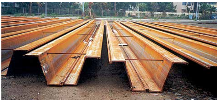
Приваренные арматурные стержни предотвращают смещение замковых соединений, что позволяет четко уложиться в проектную длину стенки.
