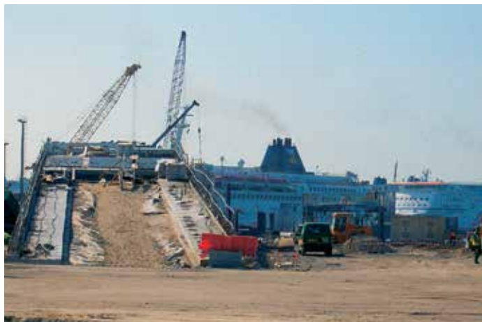
Строительство трапа на верхнем уровне.
