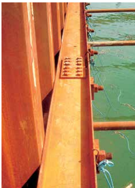
Распределительный пояс верхнего уровня анкерной системы.
