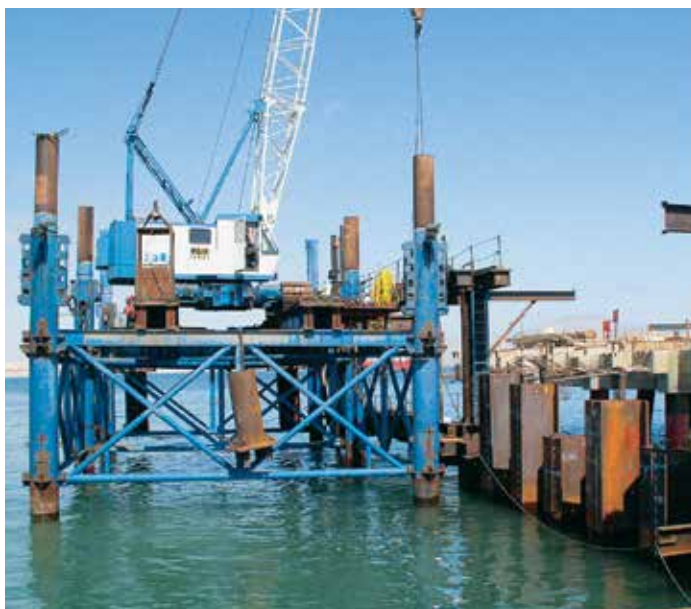
Для установки HZ/AZ-системы использовалась самоподъемная платформа и кондуктор.
