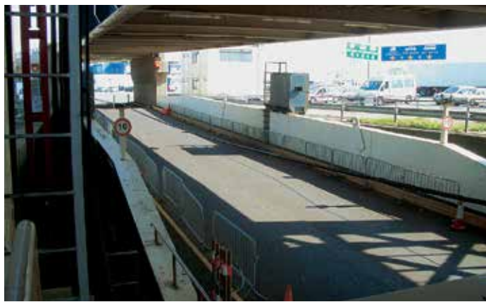
Трап на нижнем уровне соседнего Причала 8.
