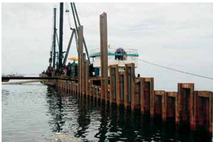
Двойные AZ-сваи AZ длиной до 21,5 м погружали с помощью оборудования, размещенного на барже.
