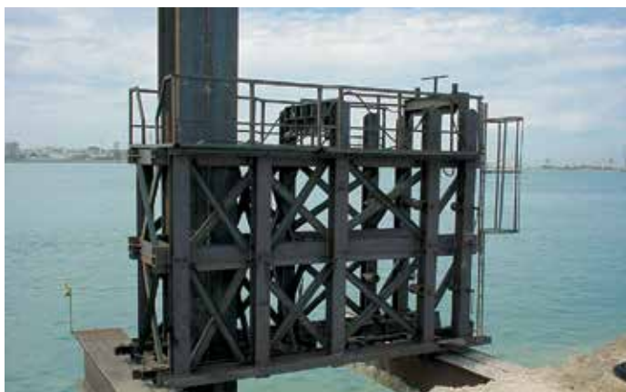
Направляющий двухуровневый кондуктор для погружения свай.
