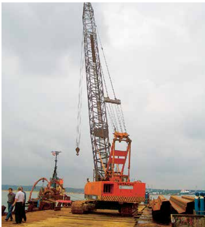
Кран для установки шпунтовых свай, размещенный на барже.
