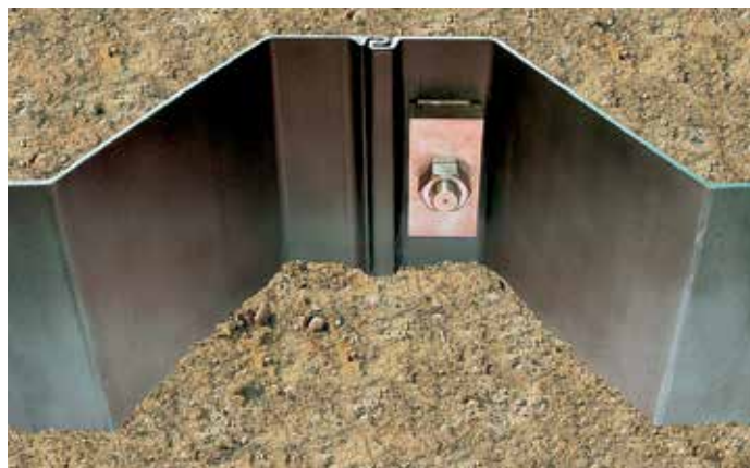
Модель узла крепления анкерной тяги нижнего уровня.
