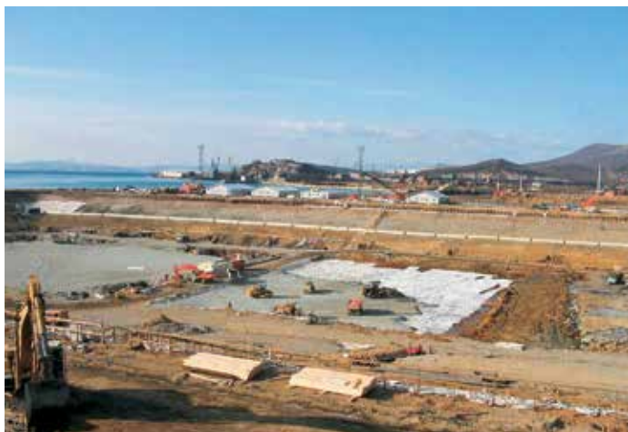
На строительство сухого дока для сооружения морских платформ потребовалось более 3000 тонн стальных шпунтовых свай.
