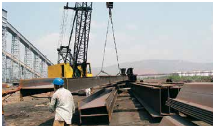
Для установки в проектное положение вибропогружателя и свай использовались два гусеничных крана.
