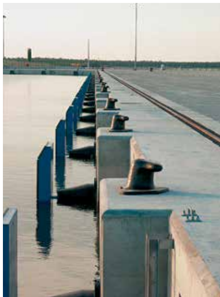
Верх шпунтовой стенки впоследствии был закрыт бетонным оголовком.
