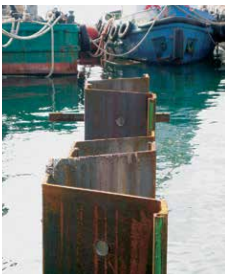
Новый пирс протяженностью 400 м будет завершен к 2006 году с использованием шпунтовых свай типа AZ 36 и AZ 18.
