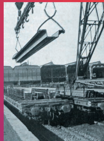
Сталеливарний завод Бельваль, Люксембург, 1930–ті рр.
