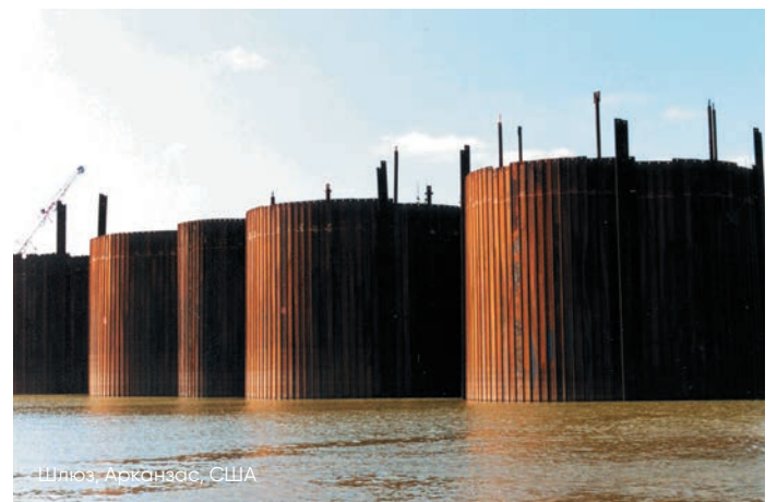
Комірки з діафрагмами зі сполучними (під кутом 120^\circ ) палями.
