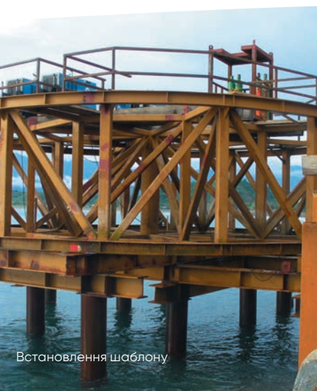
Встановлення палей до замикання комірки
