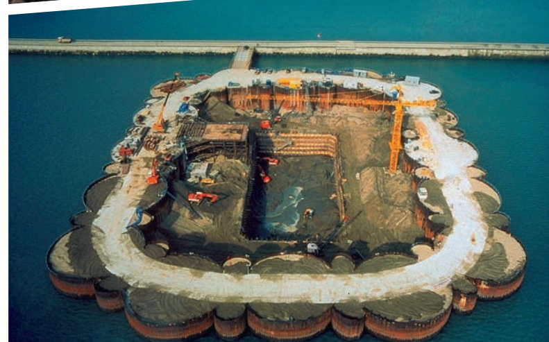
Будівництво мосту, Південна Корея
