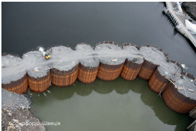
Кільцеві комірки зі сполучними (під кутом 35^\circ ) палями та однією або двома з'єднувальними арками.
