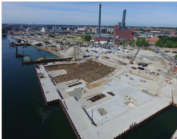
Fig. 32– Lyngholm, Myrholm & Kærholm – cofferdams and foundations.
