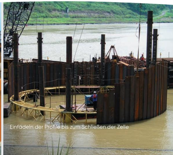
Einfädeln der Profile bis zum Schließen der Zelle
