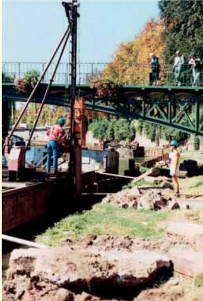
Une convention entre VNF, le Port Autonome, la Ville et la Communauté Urbaine de Strasbourg permet la restauration de ces berges sur une longueur totale de 2 800 m, consistant principalement en la réalisation d'un perré à 1/1 en moellons de grès, s'appuyant sur un rideau de palplanches.
