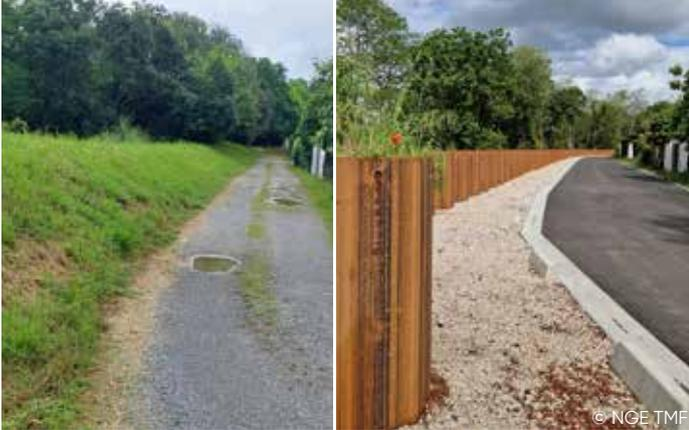
Les palplanches de type AZ 14-770 en S 355 GP de 9,2 m de long ont été installées avec un vibrofonceur monté sur mât. Dans un processus continu, la digue en terre a été effacée et les palplanches ont été vibrofoncées sur tout le linéaire. Ainsi, un avancement de 15-20 ml a été assuré, tout en garantissant la continuité de l'endiguement.
