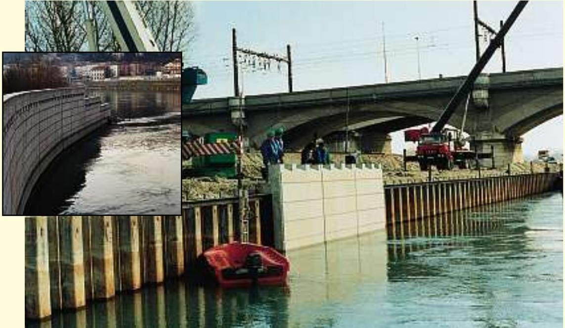
Im Verlauf der Bauarbeiten wurde das Flubbett erreicht. Direkte Eingriffe auf den Flublauf, wie die Neuprofilierung des Flubbettes, der Bau eines Stauwehres und einer Schleuse stromaufwärts, haben sich als notwendig erwiesen, um schädliche Einflüsse auf die Wasserstände zu vermeiden.
